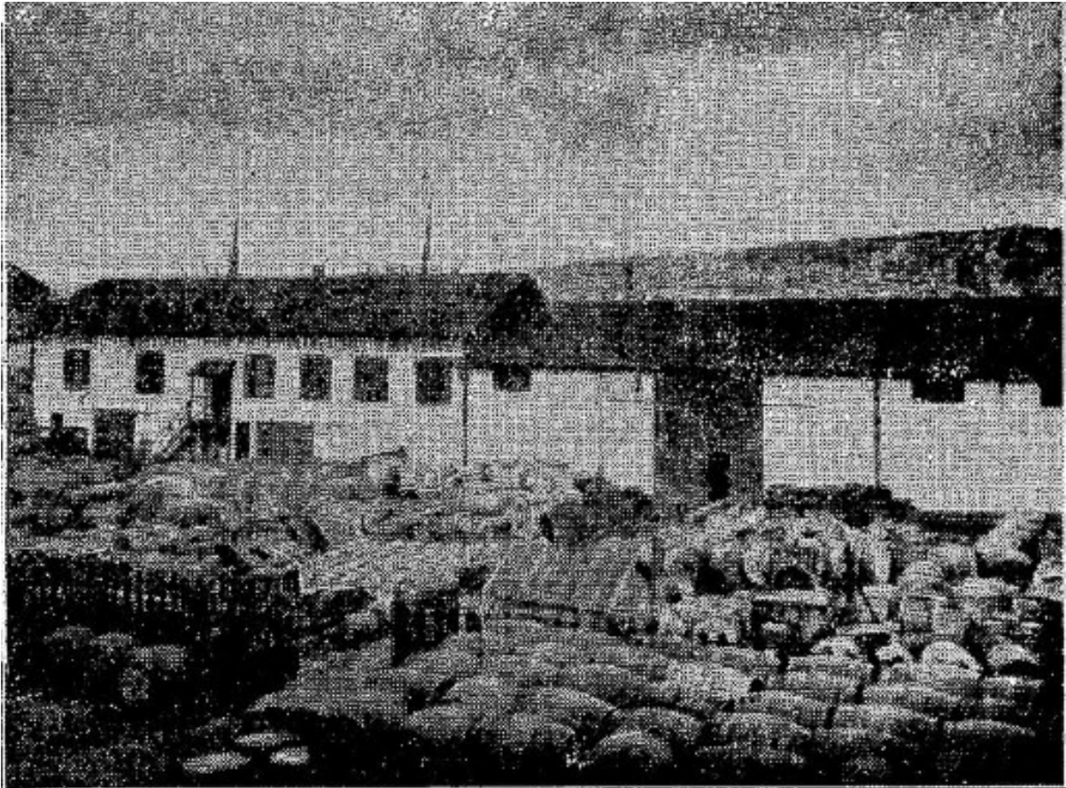
LES HANGARS DE LA SOCIÉTÉ COMMERCIALE D'ACCONAGE A ALGER
