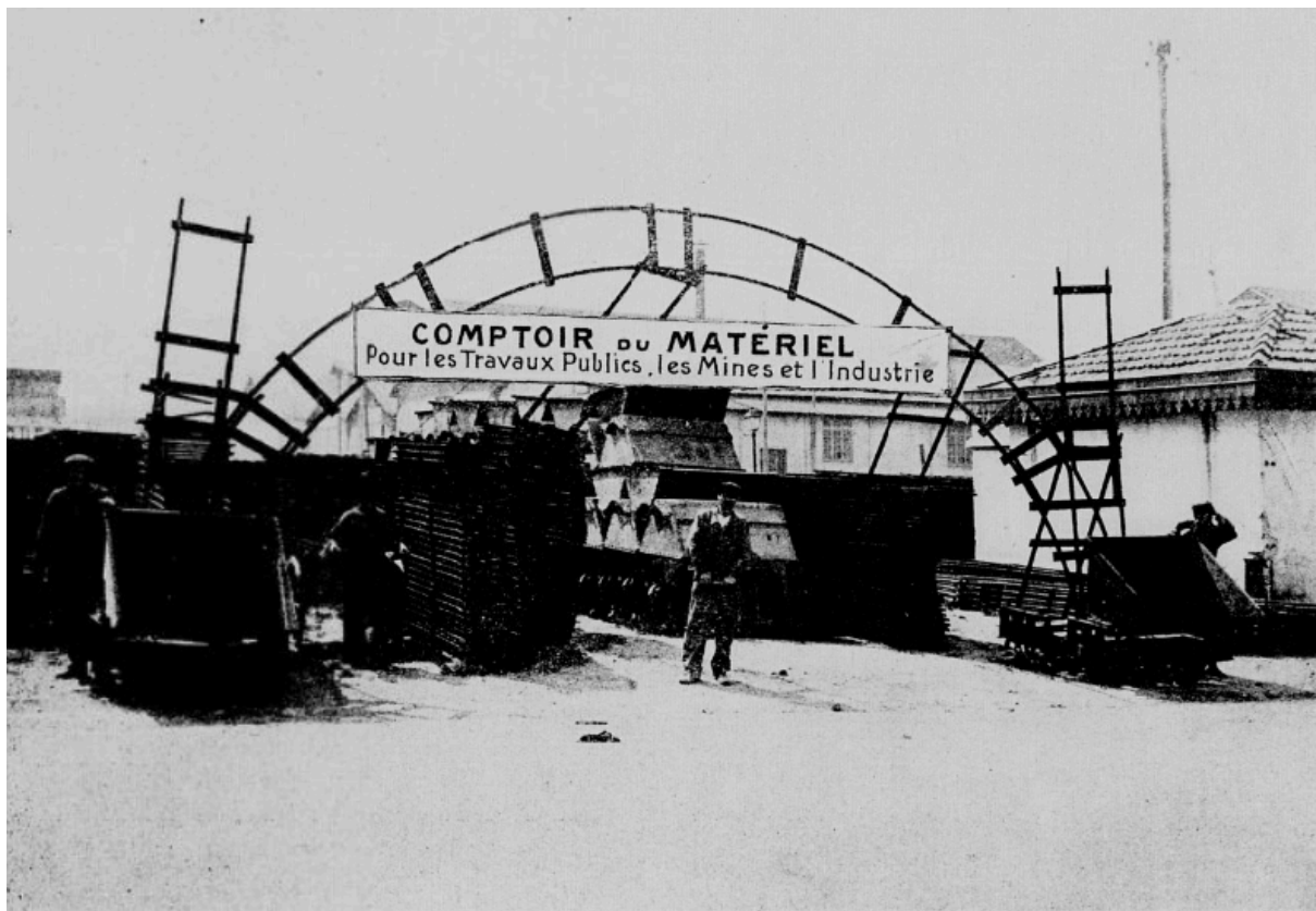
Dépôt de matériel de la Maison Decauville à l'arrière-port de l'Agha
