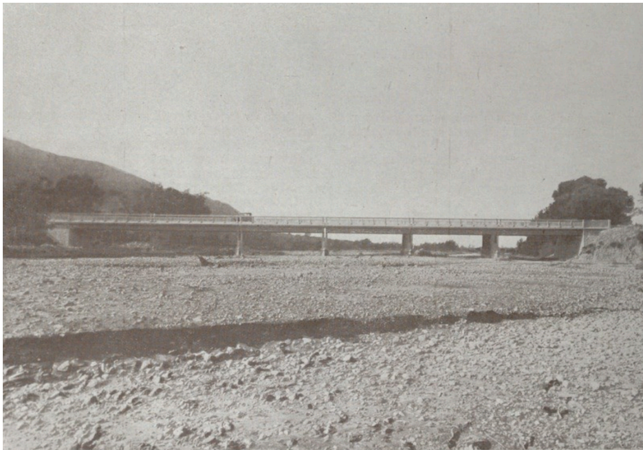
Route nationale, n° 11. — Pont sur l'oued Messelmoun.
