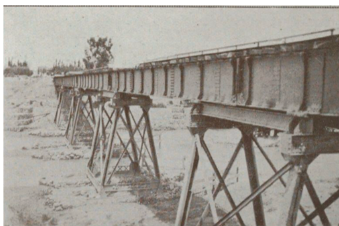
Ligne d'Alger à Oran. — Établissement de la passerelle provisoire sur l'Habra.
