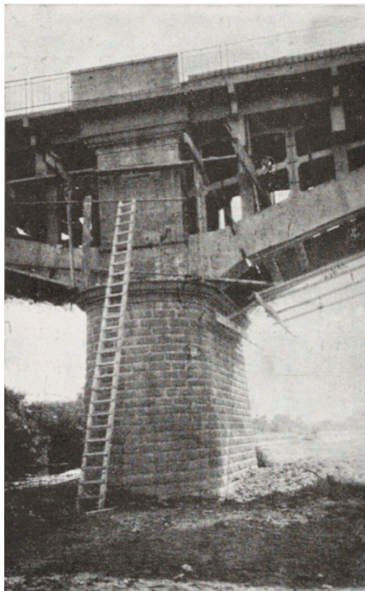
Pile médiane du pont et naissances des arcs.
