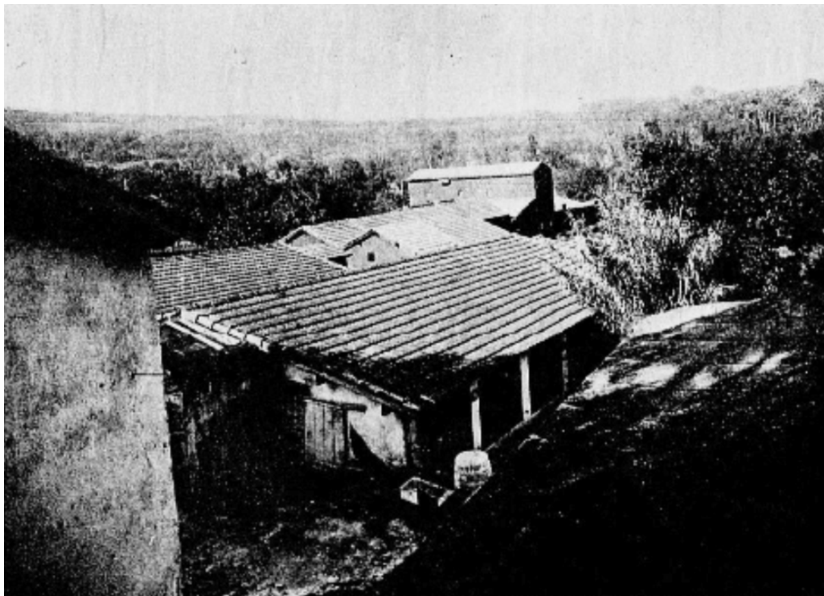
Vue d'ensemble de la boucherie
