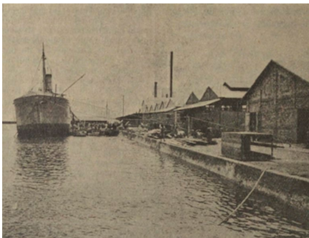
Fig. 1. — Wharf de l'usine et vapeur « Lyndiane » pendant un chargement
