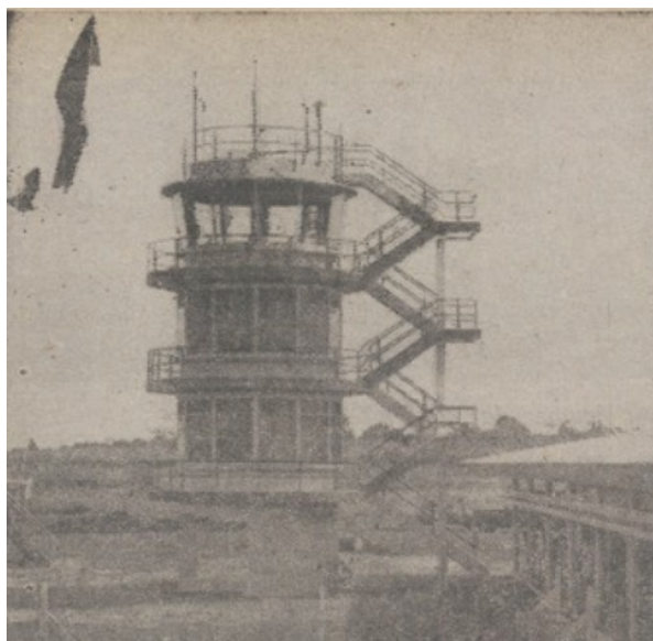
Bouaké (Côte-d'Ivoire) possède une tour de contrôle très moderne.
