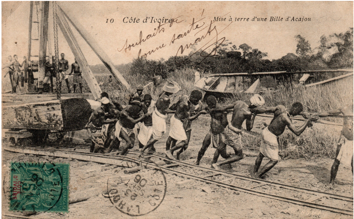
Mise à terre d'une bille d'acajou (1906).
