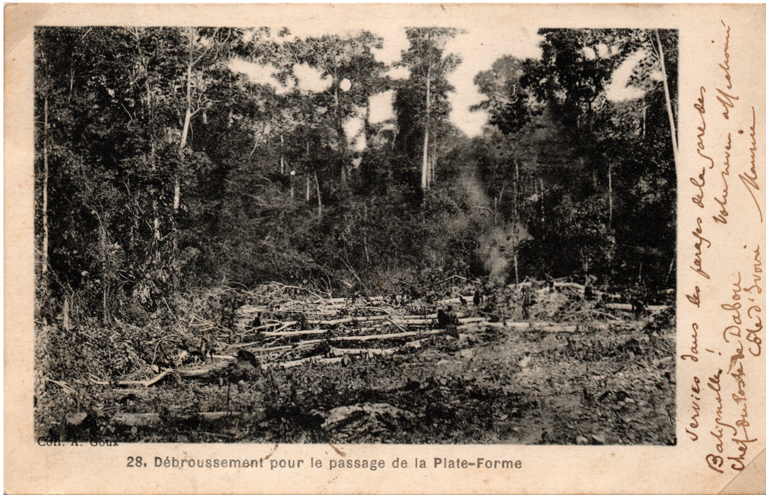
Débroussement pour le passage de la plate-forme. Coll. A. Goux Service dans le parages de la gare des Batignolles Chef du poste de Dabou (Côte d'Ivoire) Votre neveu affectionné Maurice
