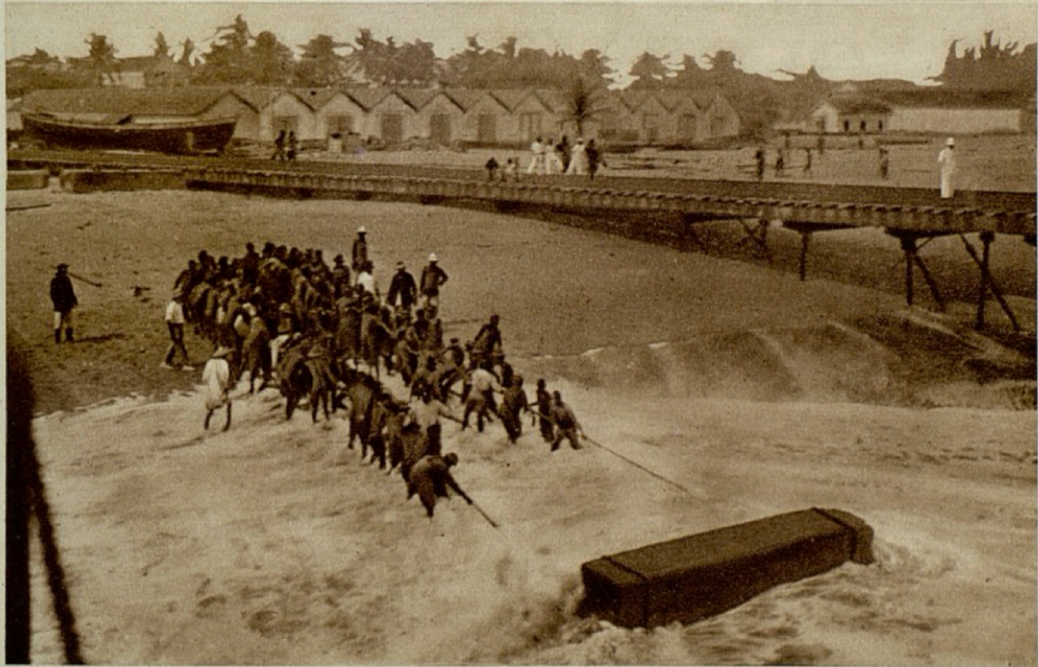
GRAND-BASSAM. Le wharf. — Sauvetage d'une bille d'acajou de dix tonnes.
