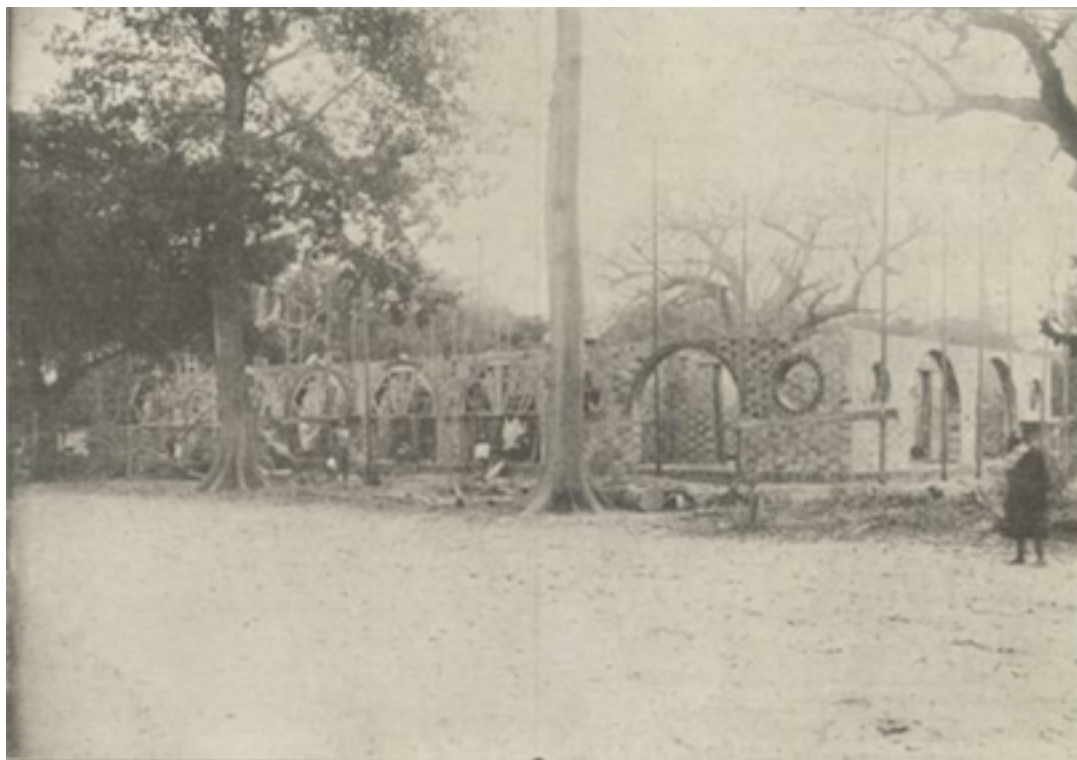
Établissements français de l'Ouest-Africain. — Construction de la gendarmerie de Thiès.
