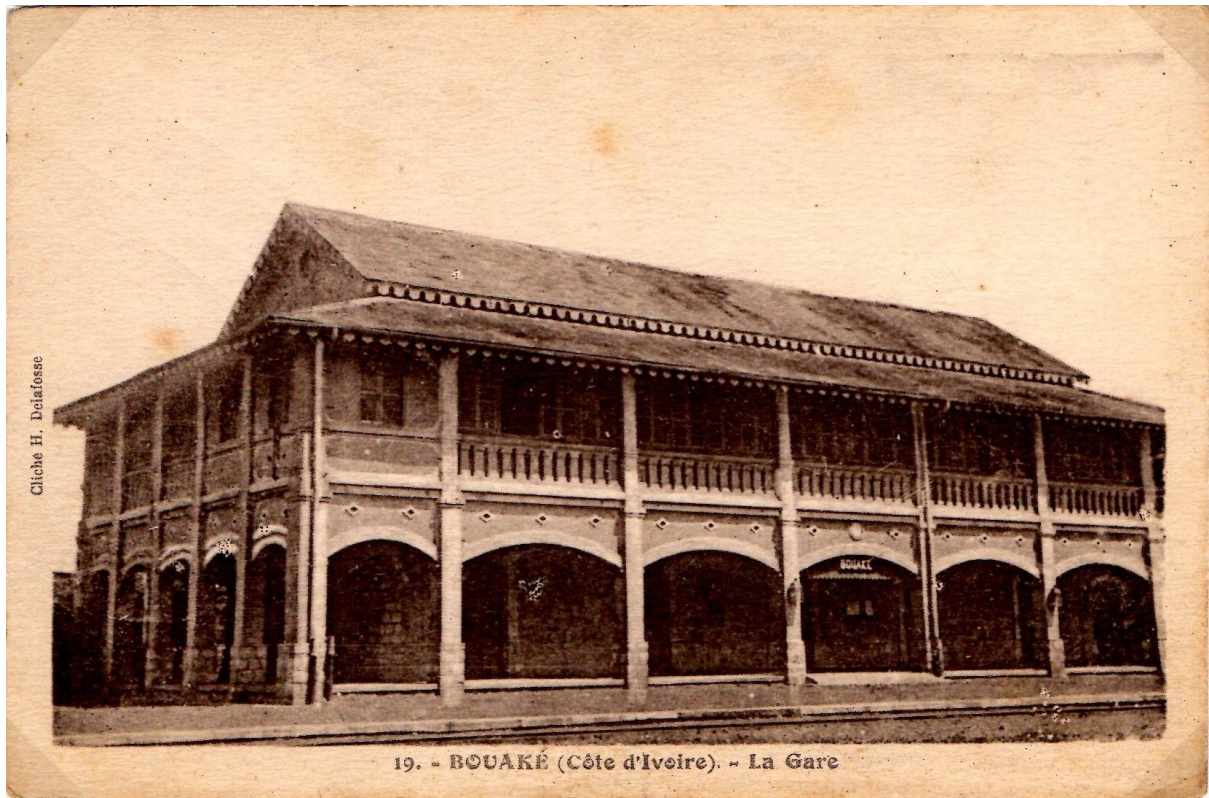
Gare de Bouaké (Cliché H. Delafosse)
