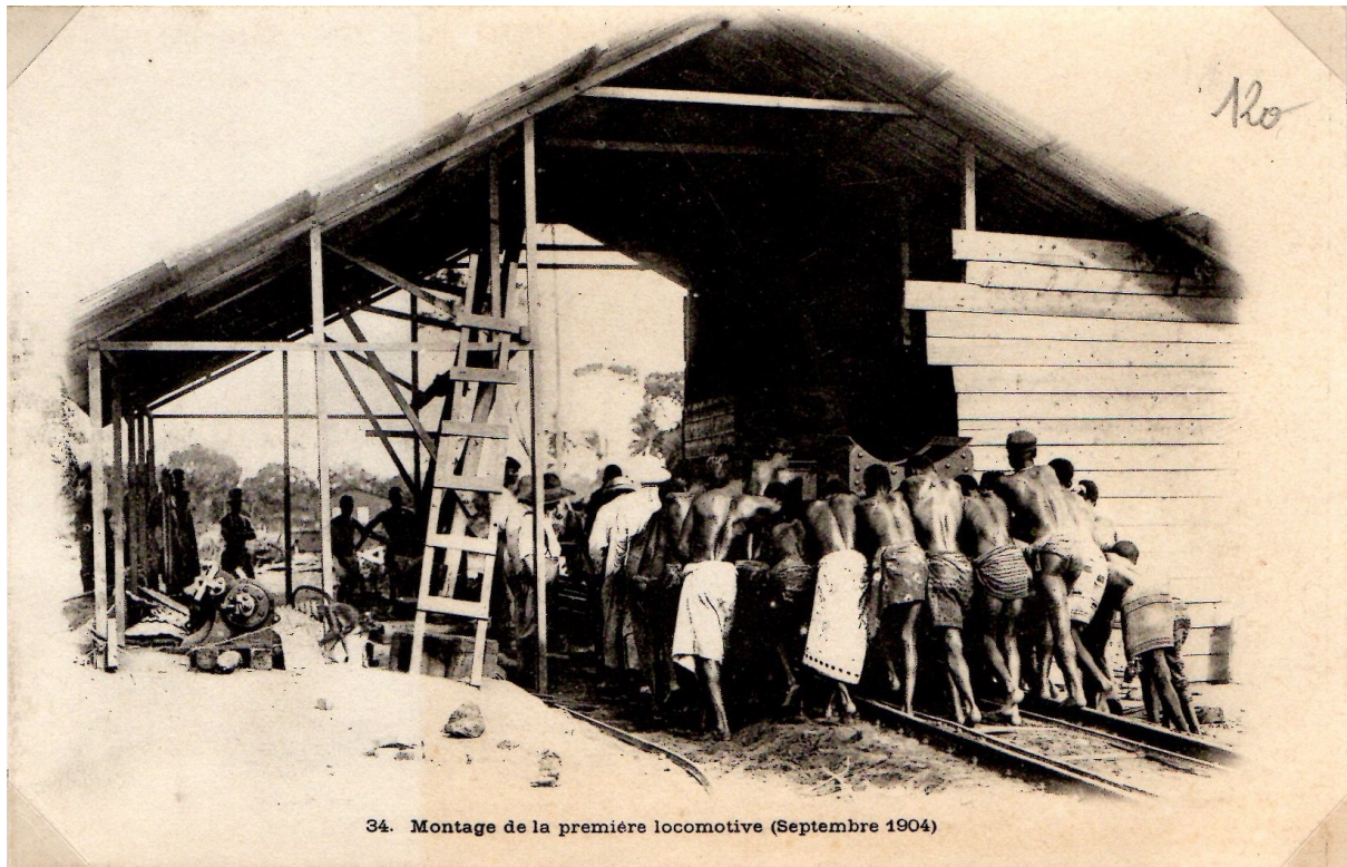
Montage des premières locomotives (septembre 1904)
