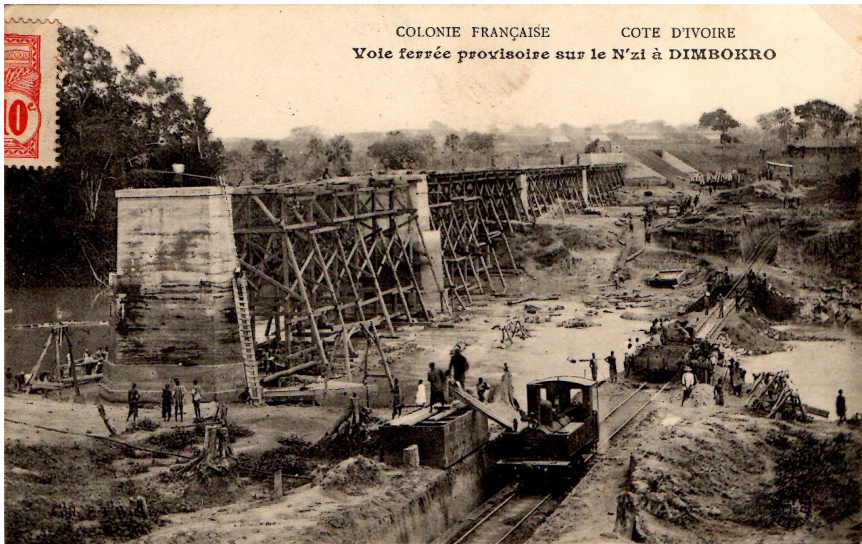
Voie ferrée provisoire sur le N'Zi à Dimbokro
