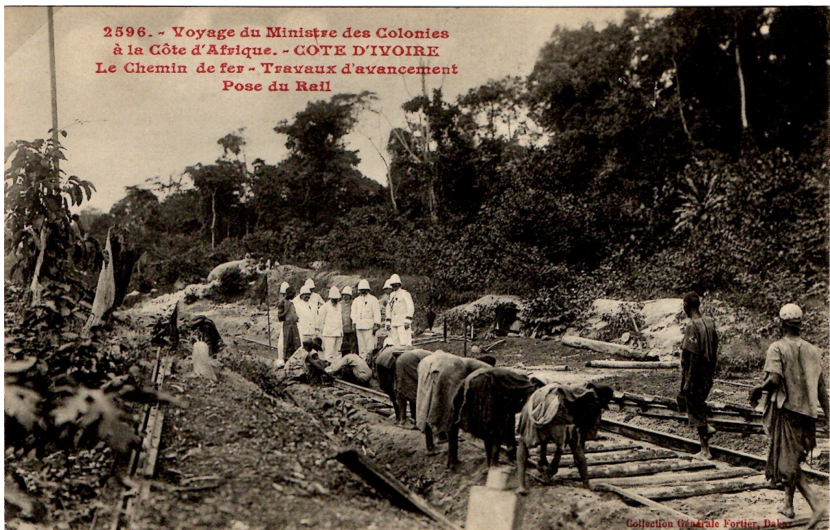
Travaux d'avancement. Pose du rail (Collection générale Fortier, Dakar. 2596)
