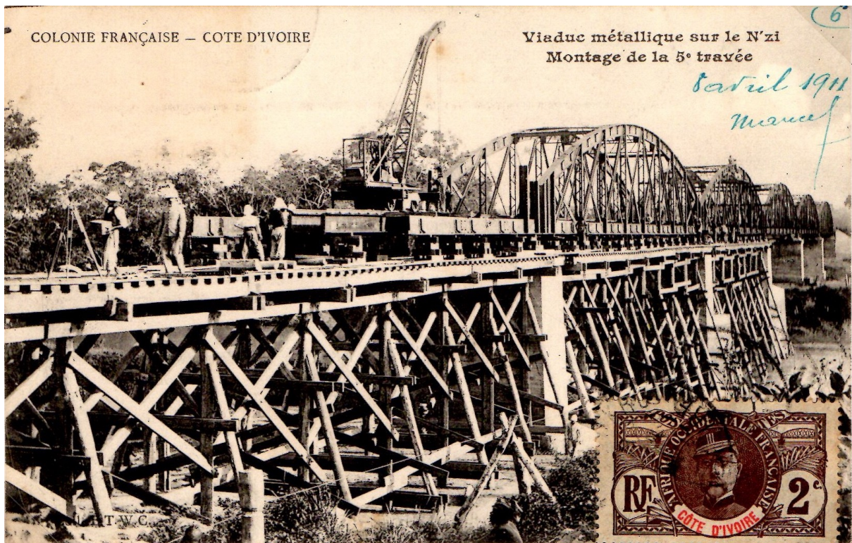
Montage de la cinquième travée (Coll. E.T.W.C.)
