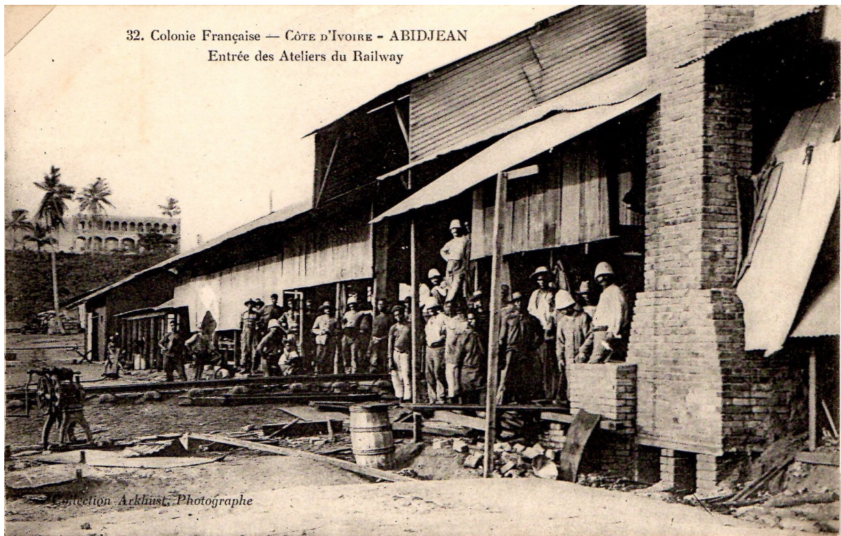
Abidjean. — Entrée des ateliers du railway (coll. Arkhust, photographe)
