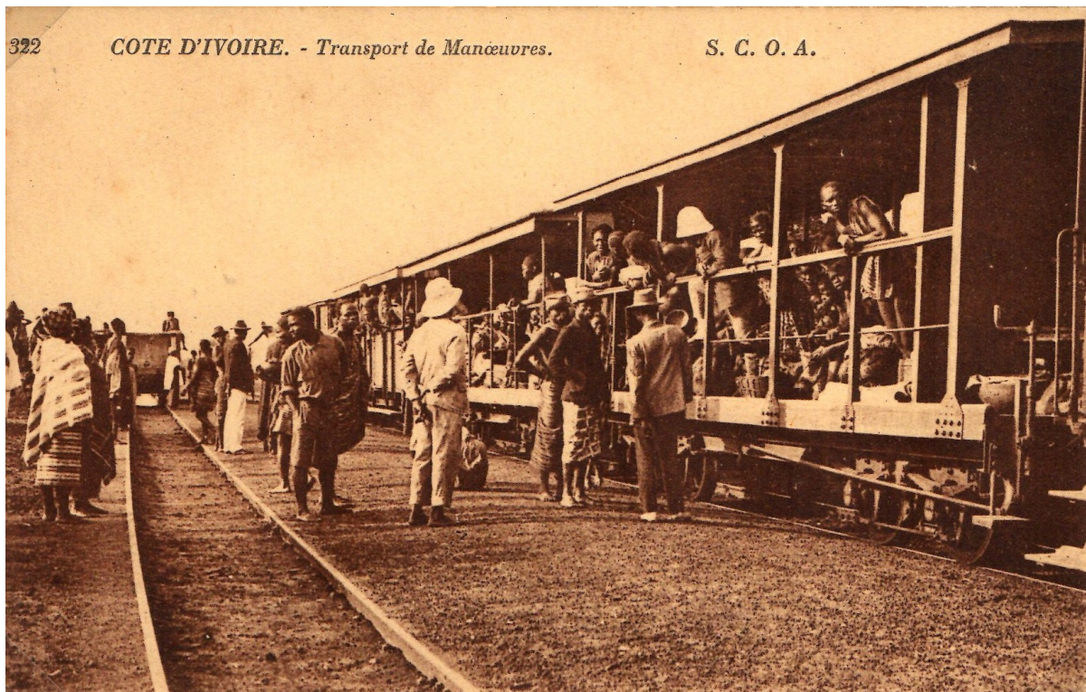
Transports de manœuvres [vers les chantiers du chemin de fer](S.C.O.A.)
