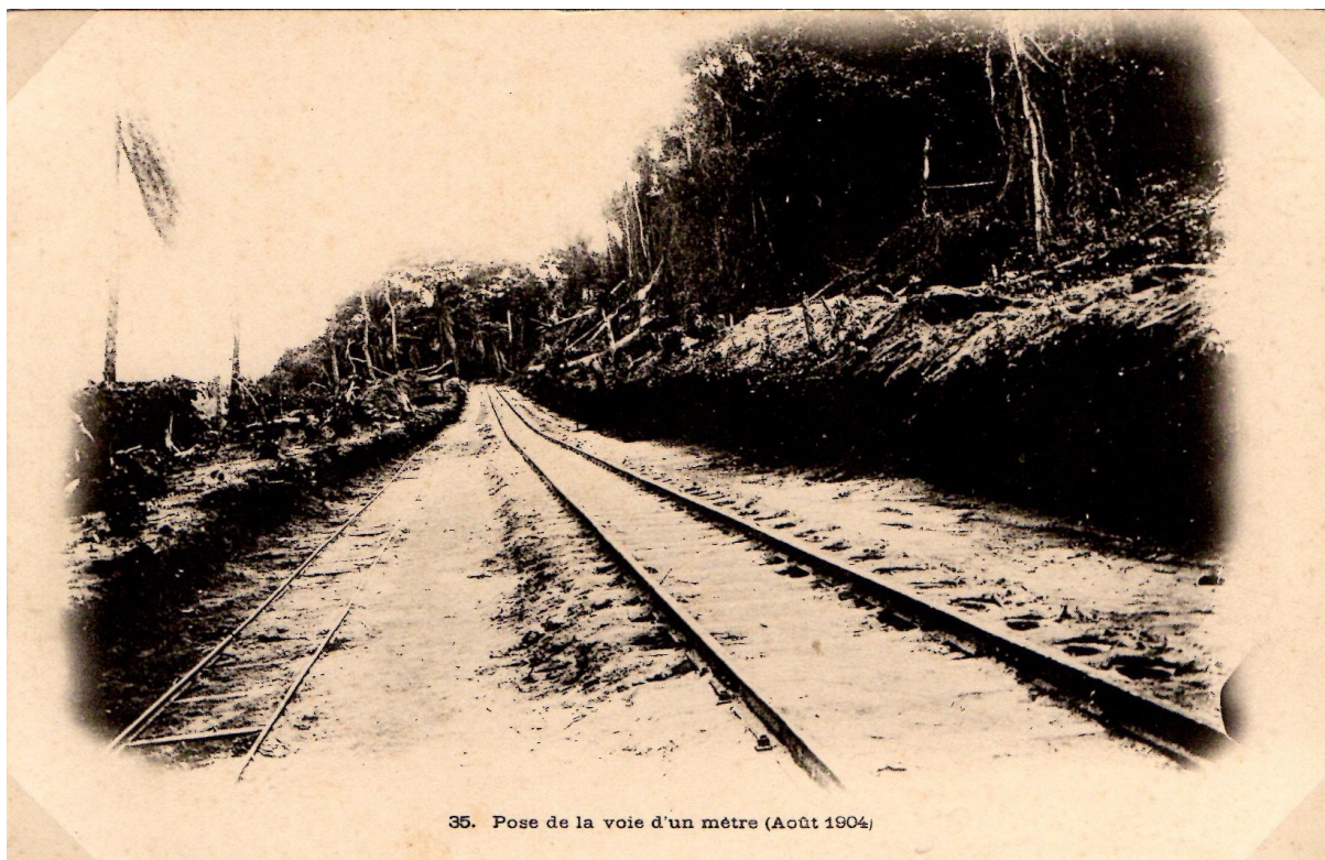
Pose de la voie d'un mètre (août 1904)
