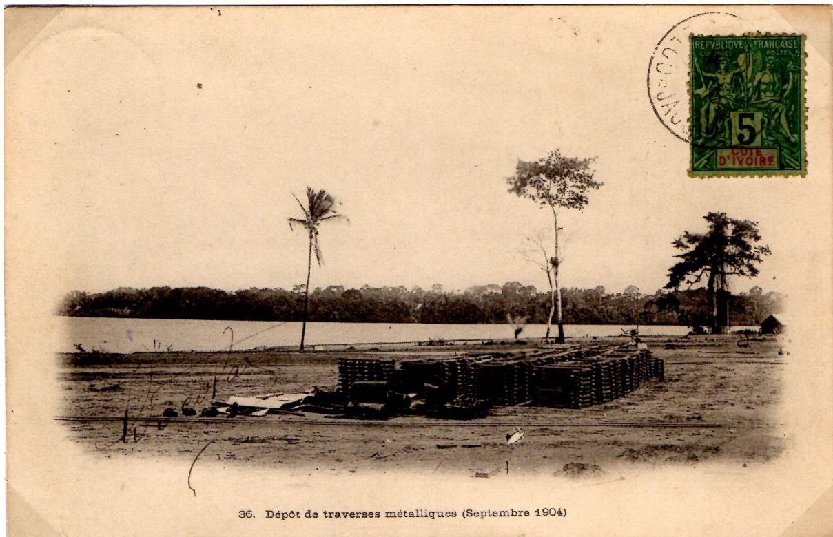
Dépôt de traverses métalliques (septembre 1904)
