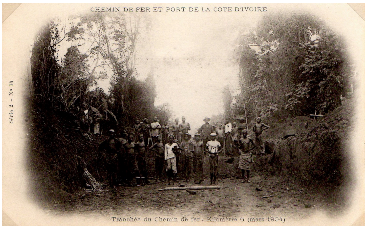
Tranchée du chemin de fer - km 6 (mars 1904)
