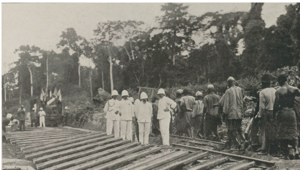
30 avril 1908. — Le capitaine Thomasset donne au ministre des explications sur la construction du chemin de fer Abidjean-Laguebey. Visite du ministre des colonies aux travaux du chemin de fer à 10 km de Laguebey.
