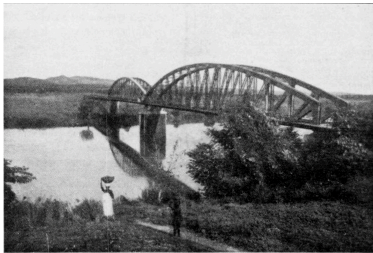
Un pont de chemin de fer sur le Niger
