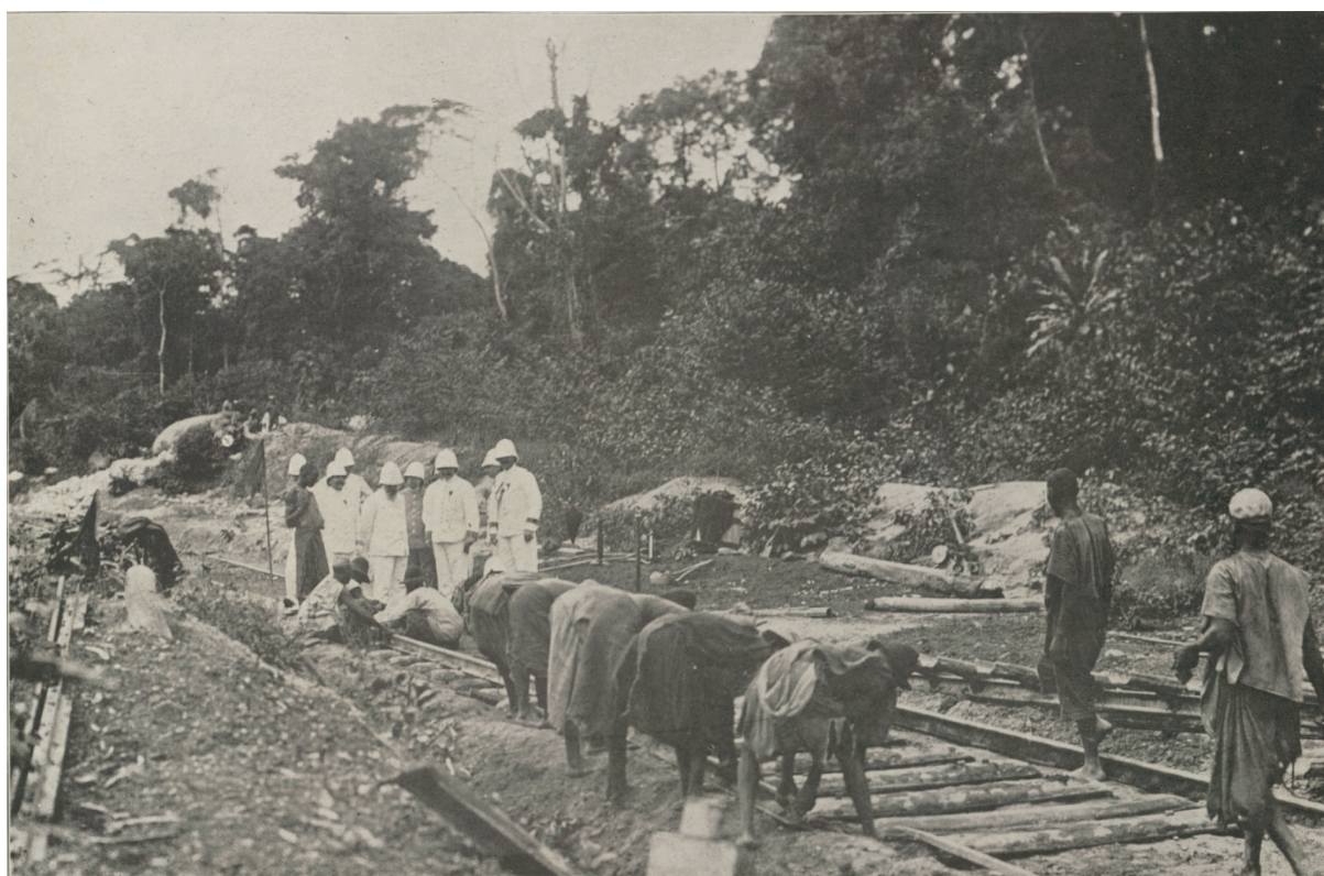
30 avril 1908. — Visite du ministre des colonies aux travaux du chemin de fer à 10 km de Laguebey.
