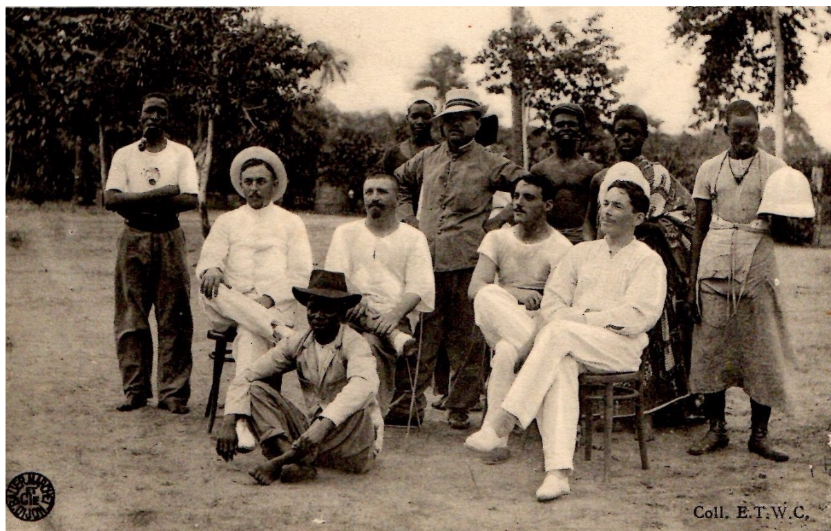
Groupe de sous-officiers du Génie détachés au. chemin de fer (Bauer-Marchal et Cie-Dijon)(Coll. E.T.W.C. )
