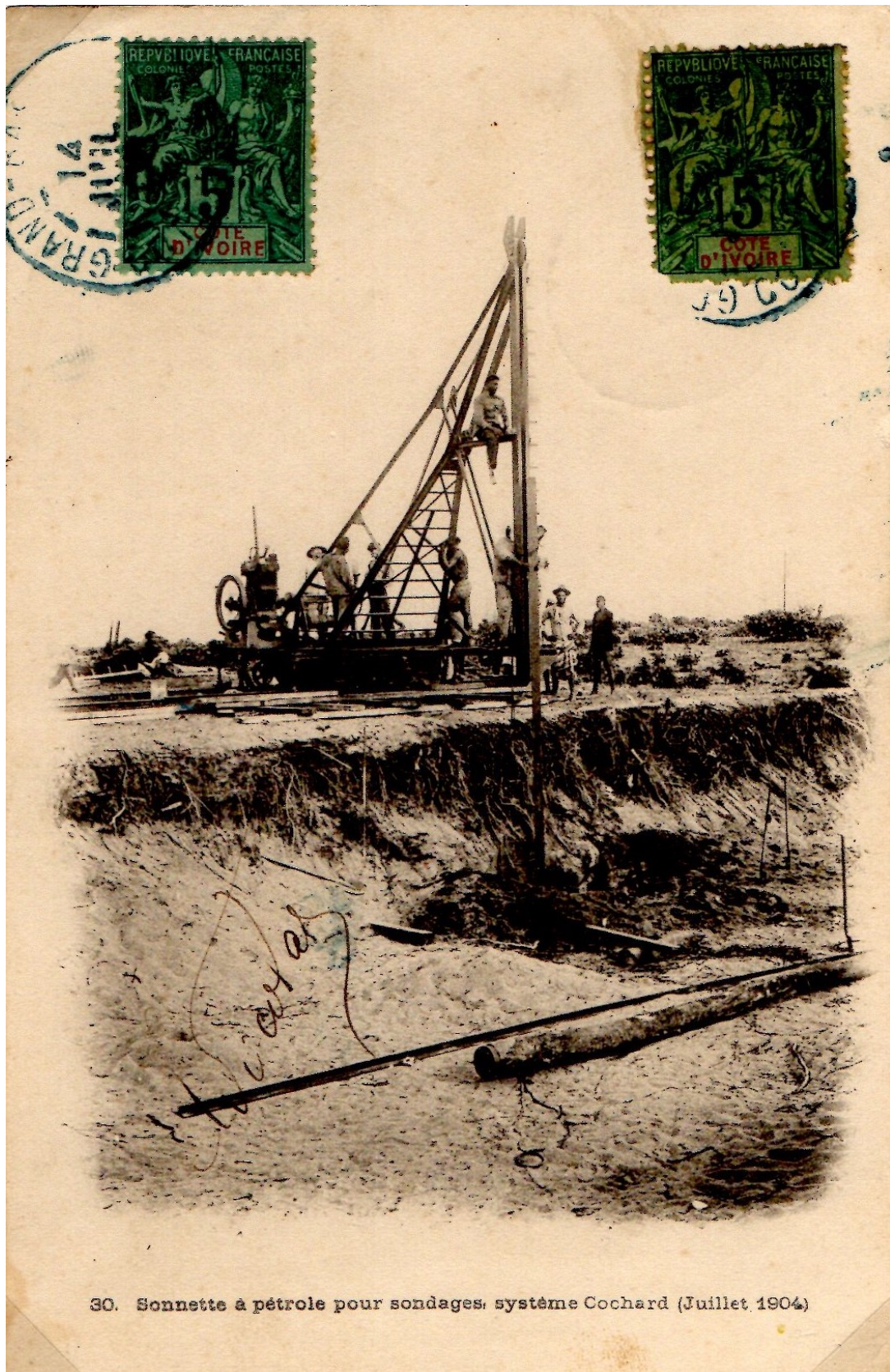
Sonnette à pétrole utilisée pour sondages, système Cochard (juillet 1904)
