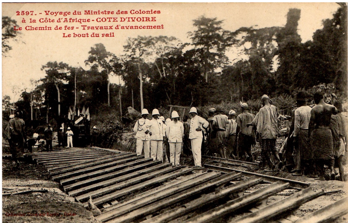
Travaux d'avancement. Le bout du rail (Collection générale Fortier, Dakar. 2597)
