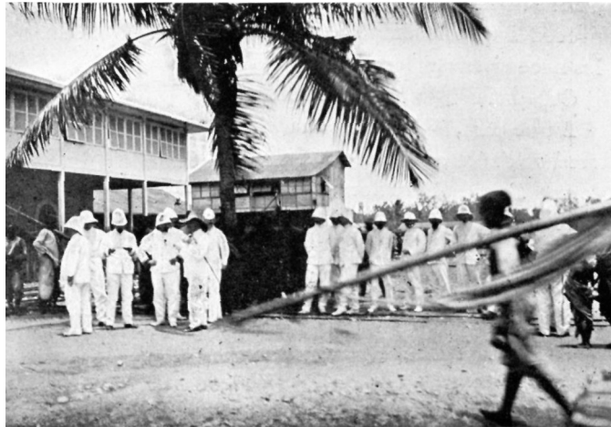
DEVANT L'IMMEUBLE DE LA BANQUE DE L'AFRIQUE OCCIDENTALE.
