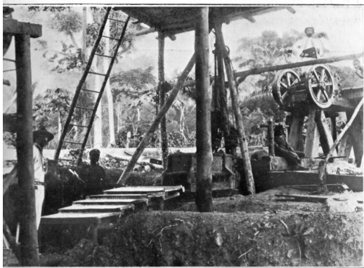
INSTALLATION D'UN MOULIN HUNTINGTON AVEC CONCASSEUR
