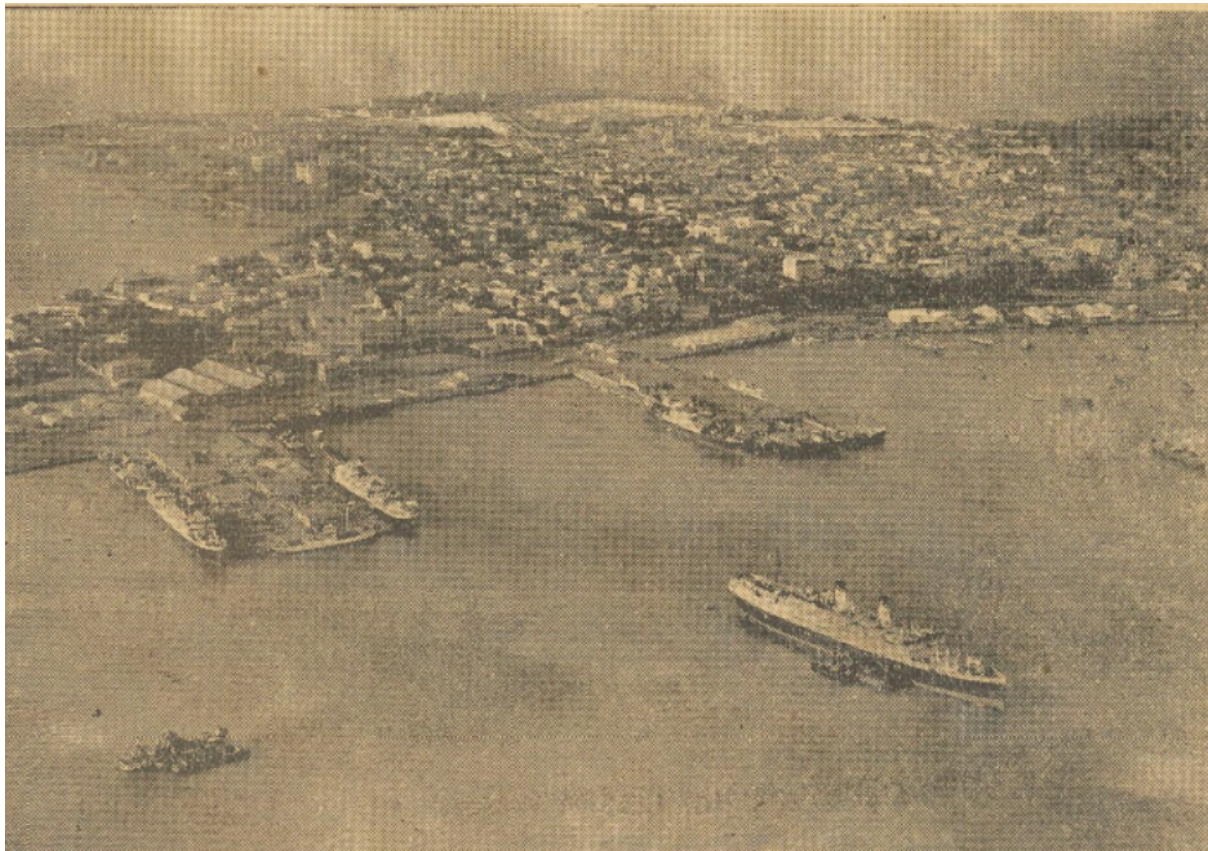
Vue aérienne du port de Dakar
