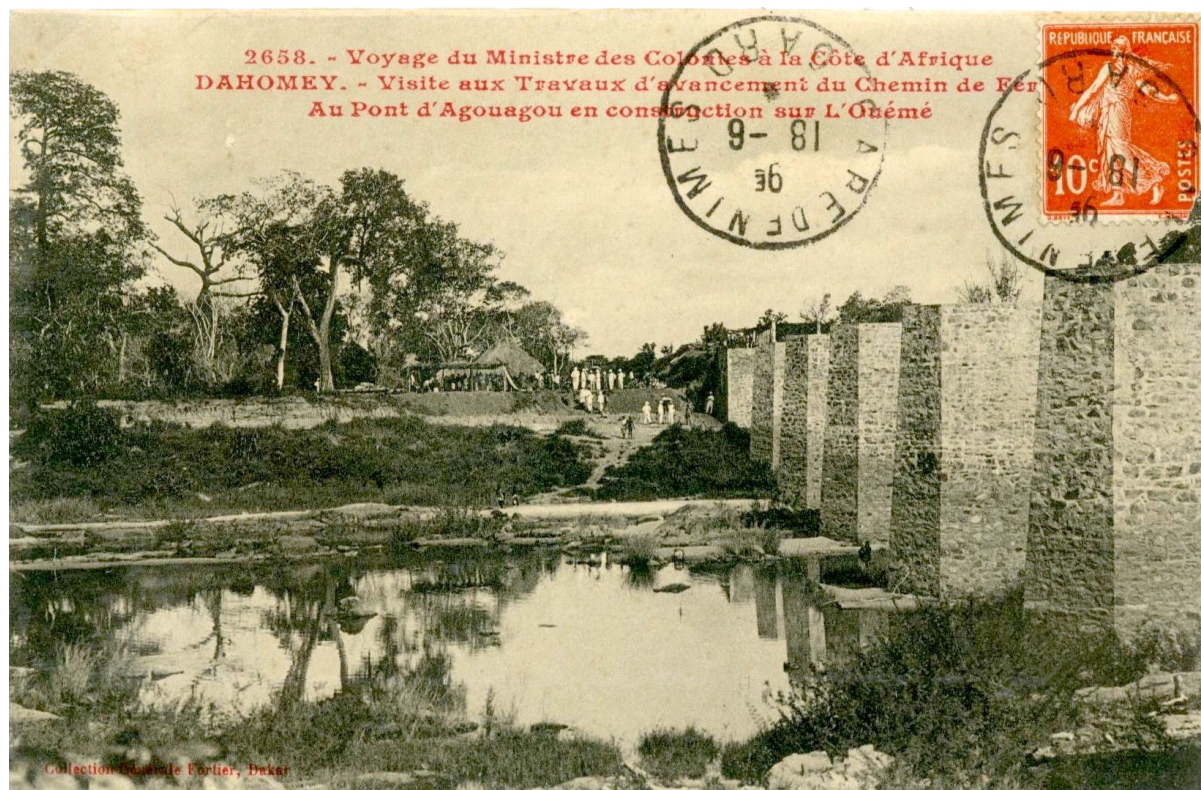
Dahomey. — Visite aux travaux d'avancement du chemin de fer. Au pont d'Agouagou en construction sur l'Ouémé. Coll. générale Fortier.
