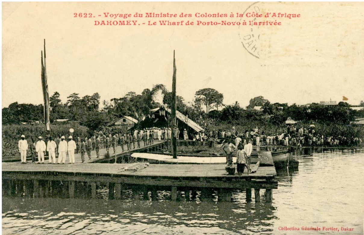
Le wharf de Porto-Novo à l'arrivée du ministre. Coll. générale Fortier.
