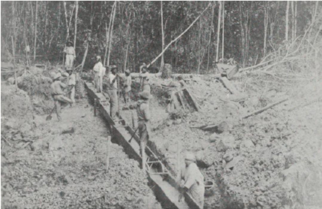
Planche IX. Placer Élysée. — Un sluice dans un chantier aurifère.
