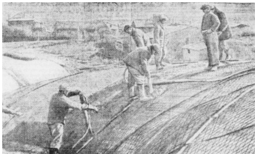
Les ouvriers au travail sur l'une des deux voûtes de cent mètres de portée des hangars de Marignane.
