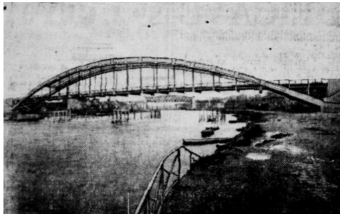
Pont de Conflans-Fin d'Oise
