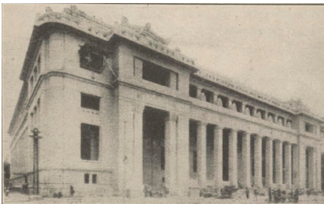
Banque de l'Indochine à Saïgon, construction en ciment armé. ( Bulletin de l'Agence économique de l'Indochine , janvier 1934)
