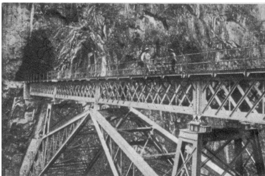
Le pont de l'Arbalétrier (province de Lao-Kay)
