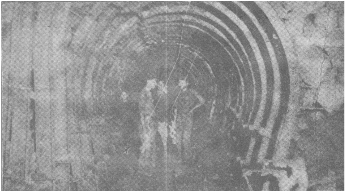
UN TYPE DE GALERIE À SOUTÈNEMENT MÉTALLIQUE
