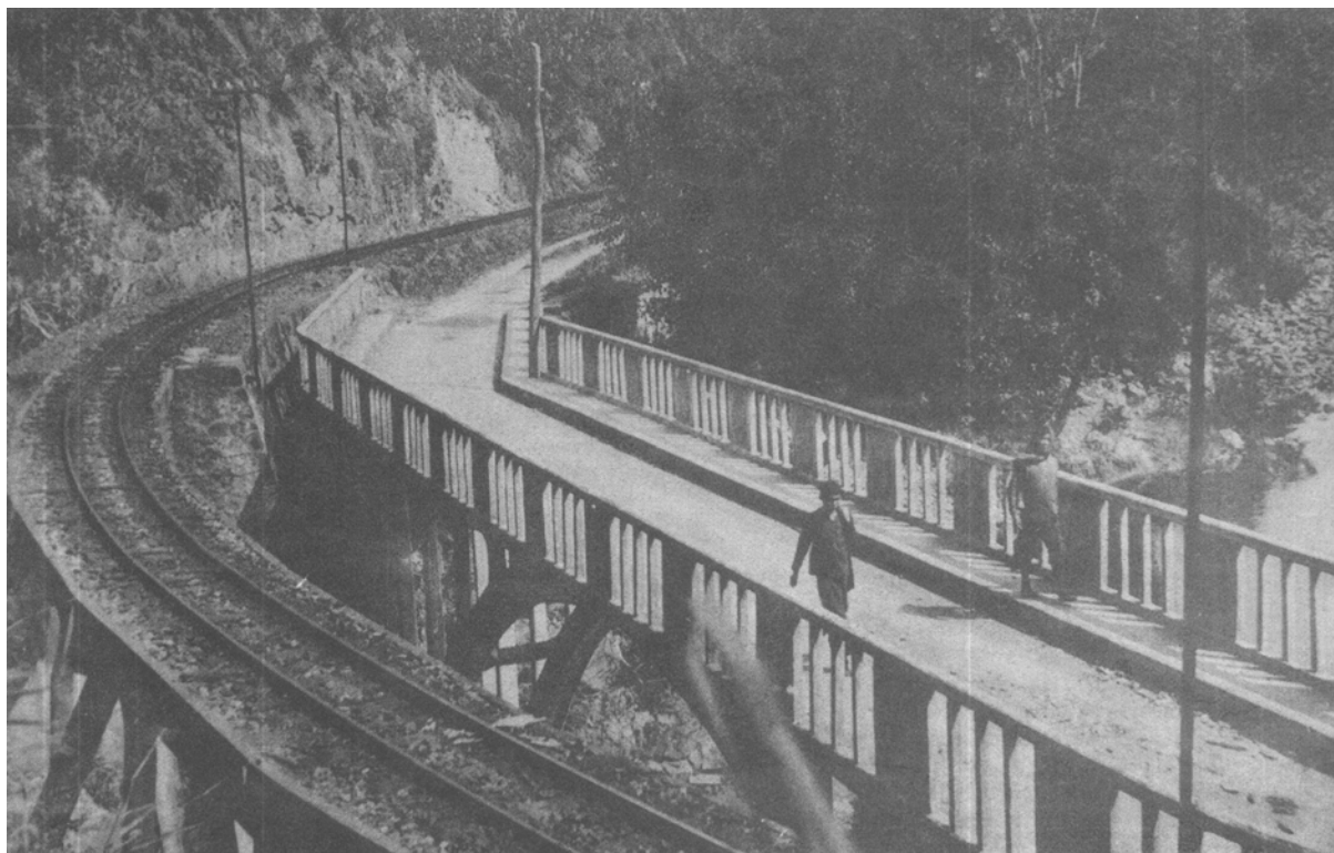
LE PONT COURBE DU KM 12, ENTRE LA MINE « CLOTILDE » ET UONG-BI, VUE DE L'ARROYO
