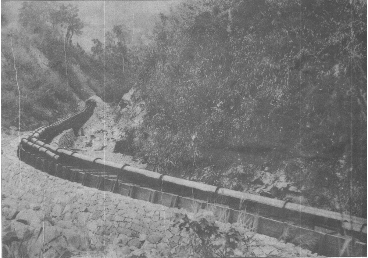
MINE « CLOTILDE ». — CONDUITE ET CANIVEAU CAPTANT L'EAU DANS L'ARROYO POUR ÉVITER SON INTRODUCTION DANS LA MINE
