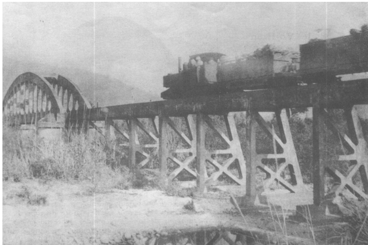
LE PONT EN BÉTON ARMÉ, DIT « PARABOLIQUE », DU KM 9, ENTRE LA MINE « CLOTILDE » ET UONG-BI
