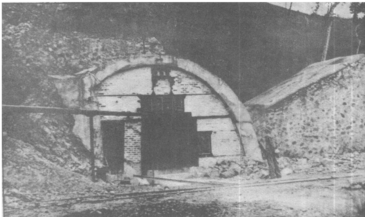
MINE « CLOTILDE ». — LE VENTILATEUR ASPIRANT DE 80 CV. DU NIVEAU 275
