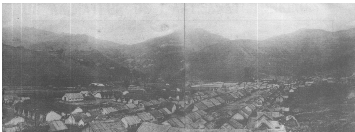
VUE GÉNÉRALE DU VILLAGE MINIER DE LA MINE CLOTILDE. — Au premier plan à gauche : L'HÔPITAL. Au fond, sur les mamelons : LES VILLAS DU PERSONNEL EUROPÉEN
