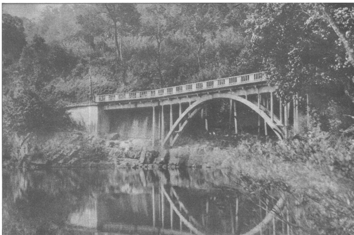
LE PONT COURBE DU KM 12, ENTRE LA MINE « CLOTILDE » ET UONG-BI
