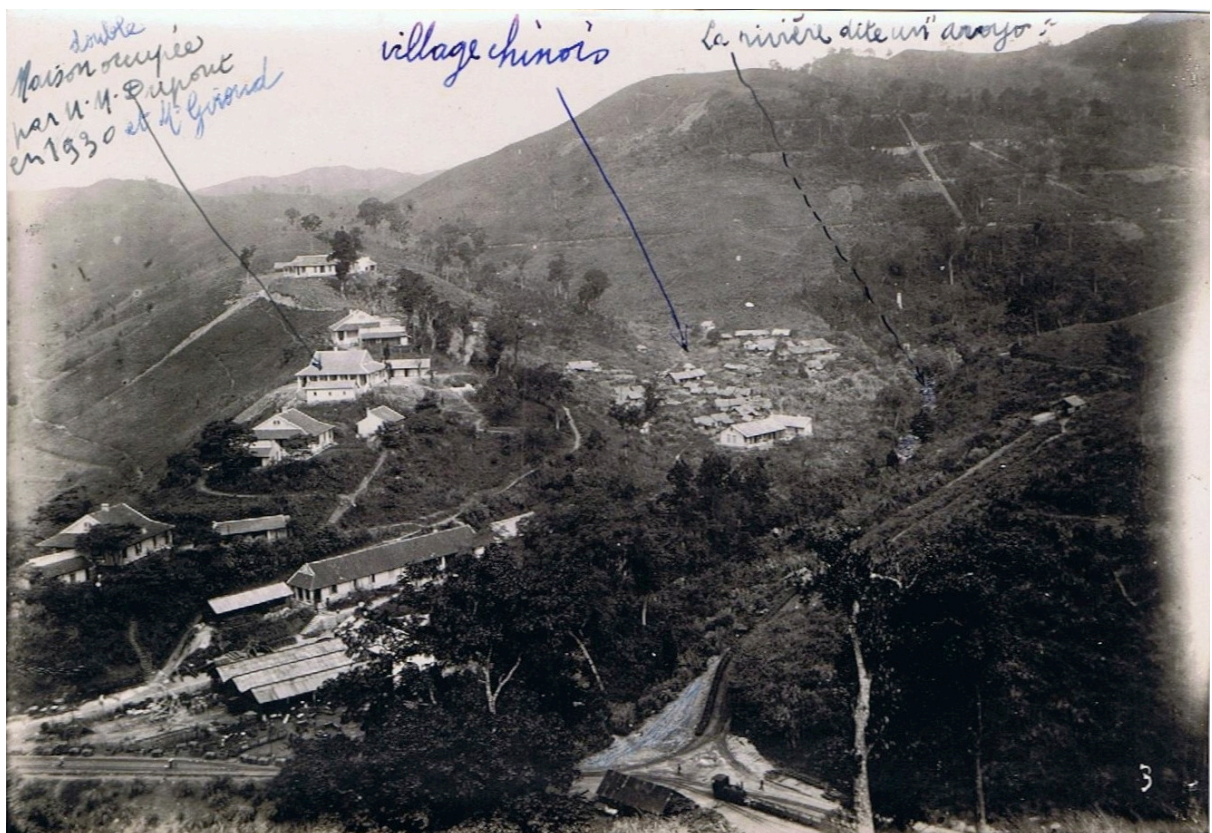
À gauche : les maisons des cadres et les bureaux. À droite : le village chinois. À ses pieds : un arroyo.
