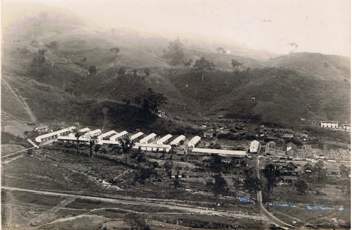
Le village minier. À droite : bâtiments en construction
