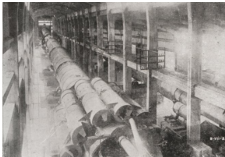
Fours rotatifs de 300 tonnes (longueur : 106 mètres)
