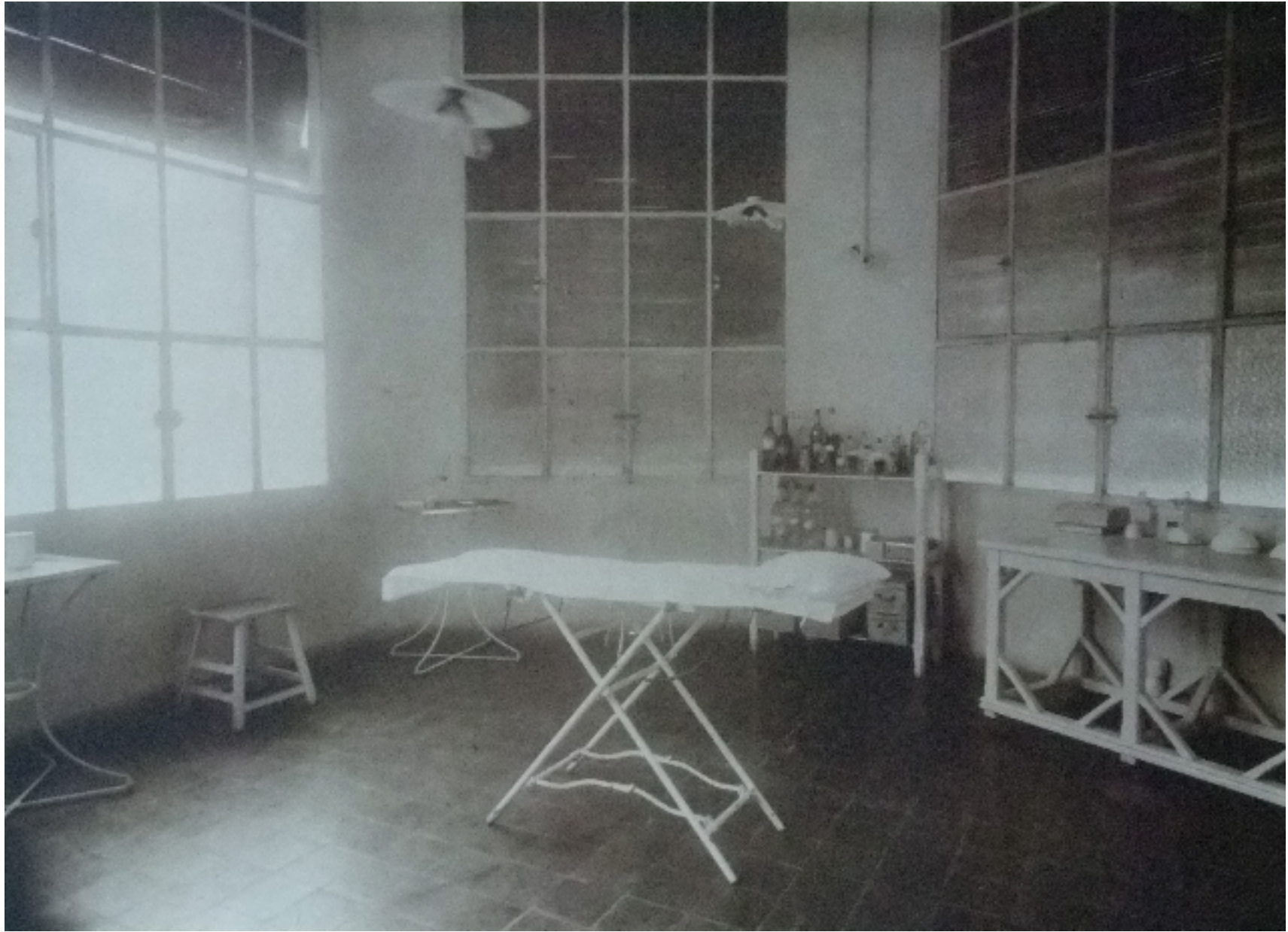
Salle d'opérations septique
