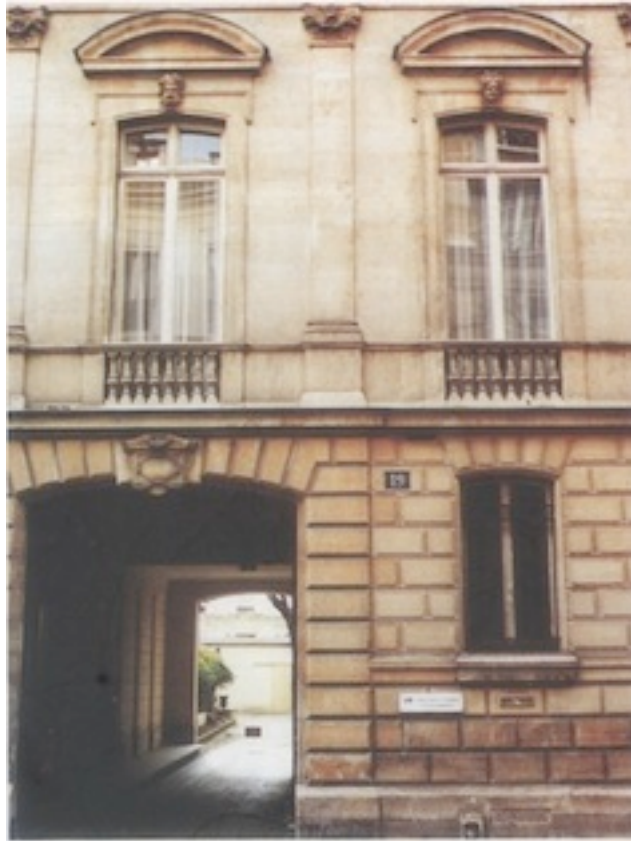
Paris, 19, rue de Calais (9 e ). — Immeuble de bureaux acquis en 1987.
