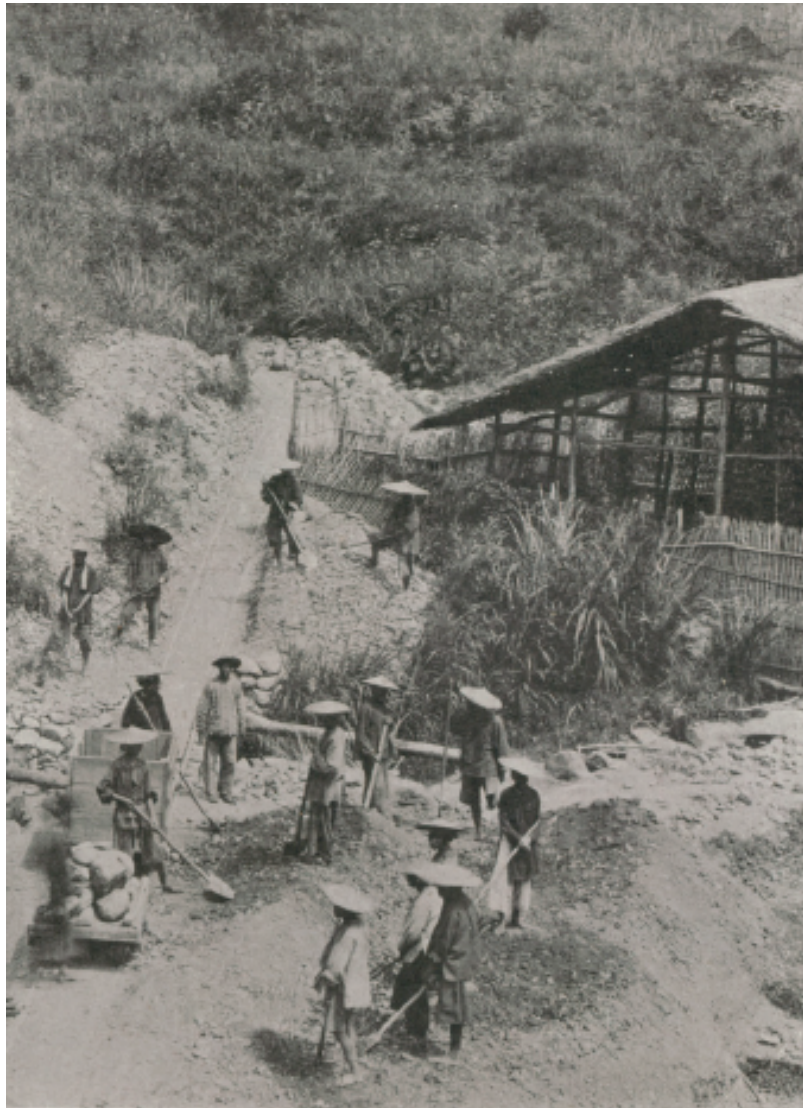
MINES D'ÉTAIN DE TINH-TUC (TONKIN) — DÉBLAIEMENT DES TERRES STÉRILES
