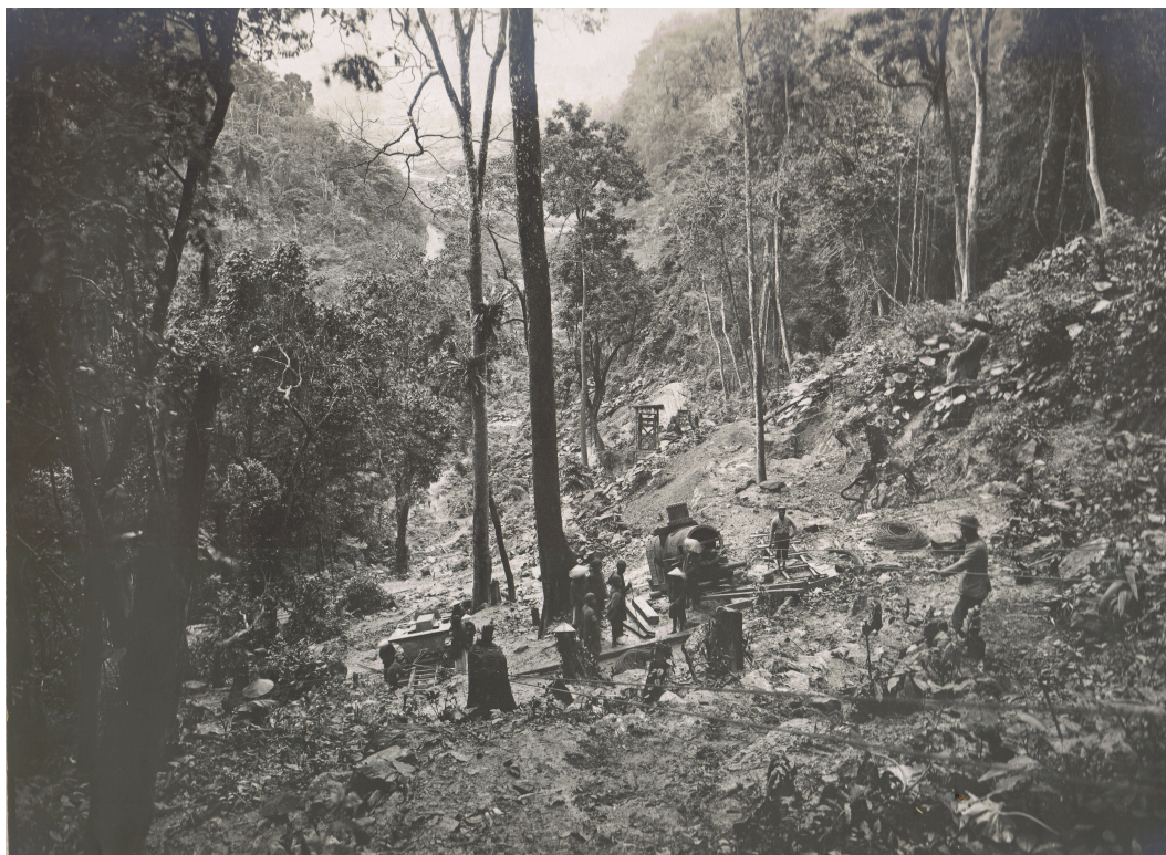
Montée d'une locomotive (chaudière et châssis) à Moba.
