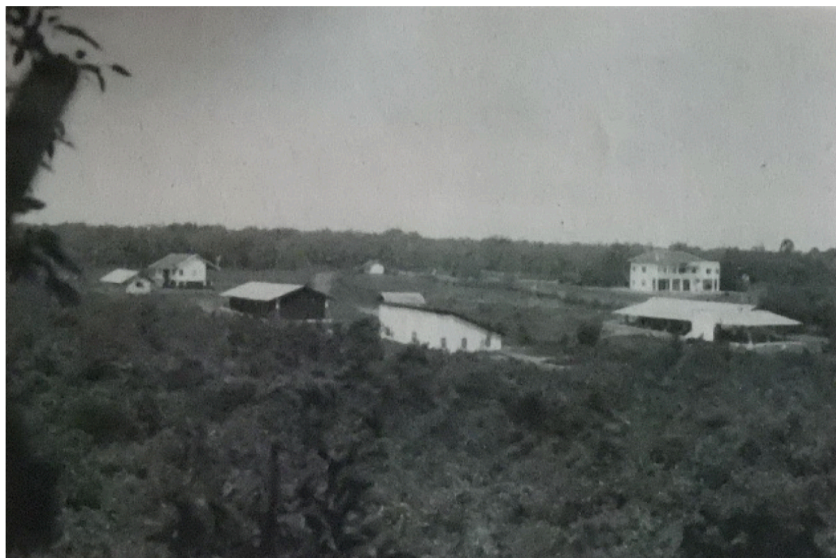
Vue générale des installations (Pl. 84)
