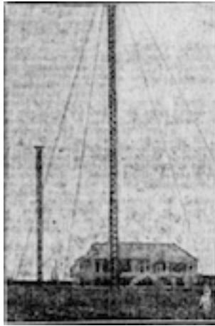
Poste de Radio-Saïgon à Chi-Hoa (vue d'ensemble)
