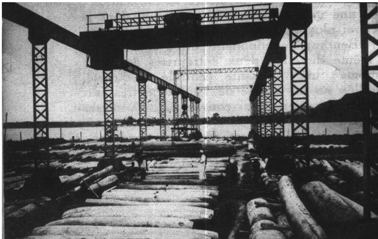
Le pont roulant
