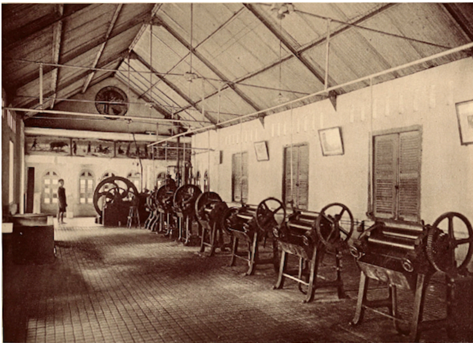
Planche 79. — Intérieur de l'usine.
