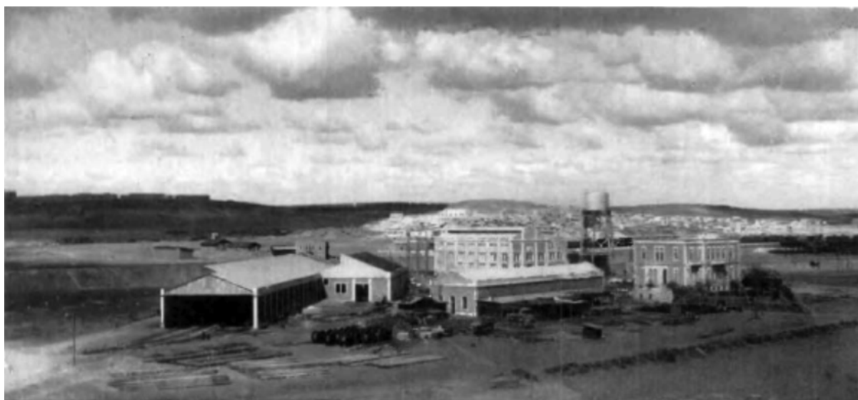
Vue générale de la centrale.
