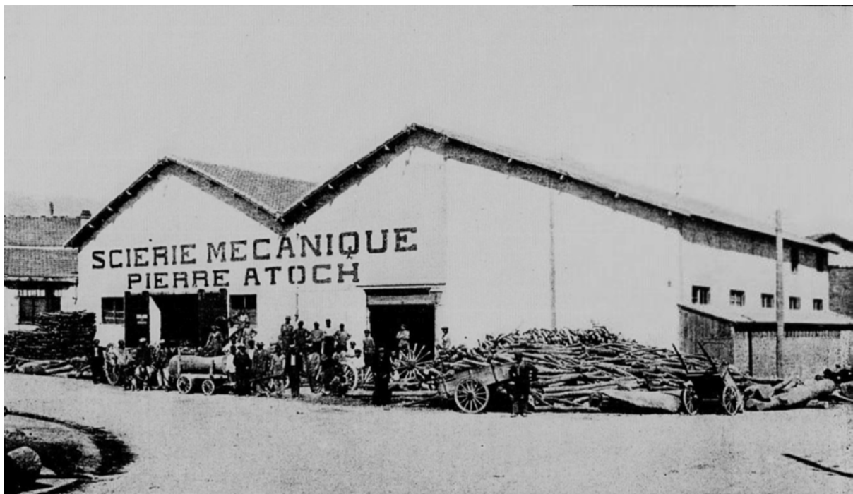
La scierie mécanique de la Maison Pierre Atoch
