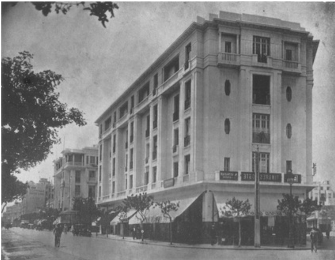
Immeuble Tazi, rue Galliéni et boulevard de Paris, construit par M. J.-B. Battaglia [102]
