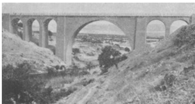
Pont de chemin de fer sur la ligne de Fès à Oujda
