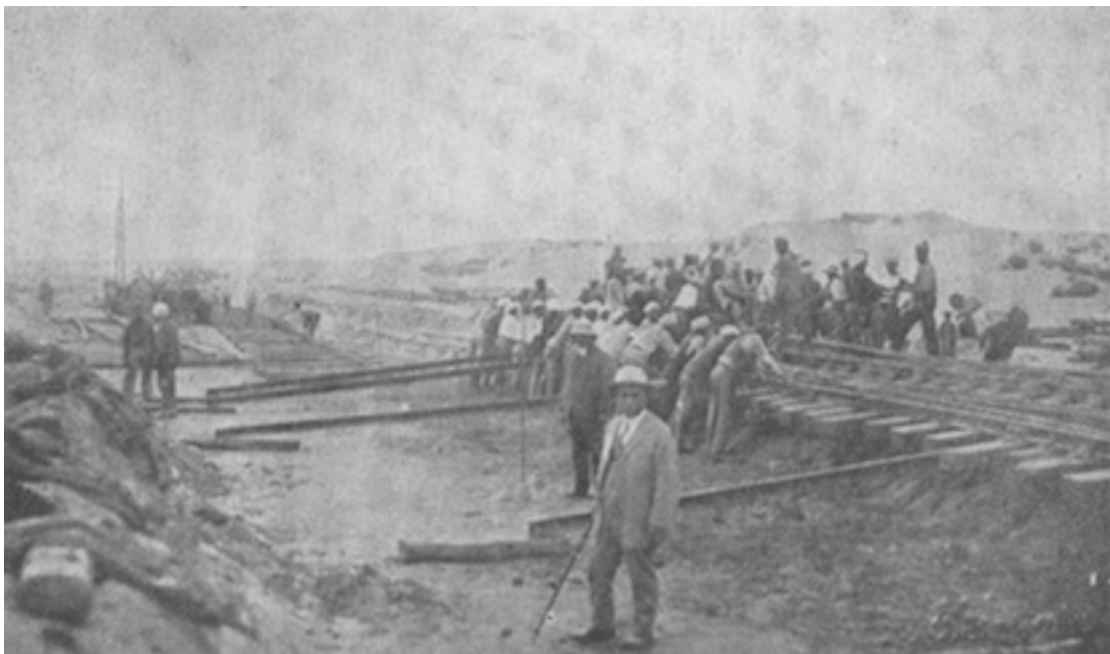
Déplacement d'un faisceau de voie à la gare des Roches-Noires à Casablanca, côté Rabat, pour raccorder l'ancienne voie des phosphates avec la voie actuelle.
