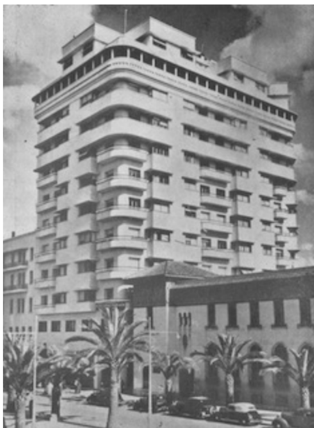
Immeuble de MM. Moretti et Milone, place de France, Casablanca. Tout le confort moderne : 5 ascenseurs rapides, chauffage central, eau chaude, adoucisseurs d'eau,
