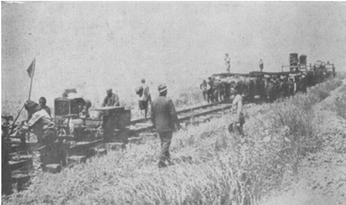
La pose des voies des chemins de fer nécessite un outillage considérable. Voici une pose de voie à l'avancement par le moyen d'appareils mécaniques avec la tirefonneuse mécanique. Au premier plan, à gauche, on distingue la tirefonneuse.
