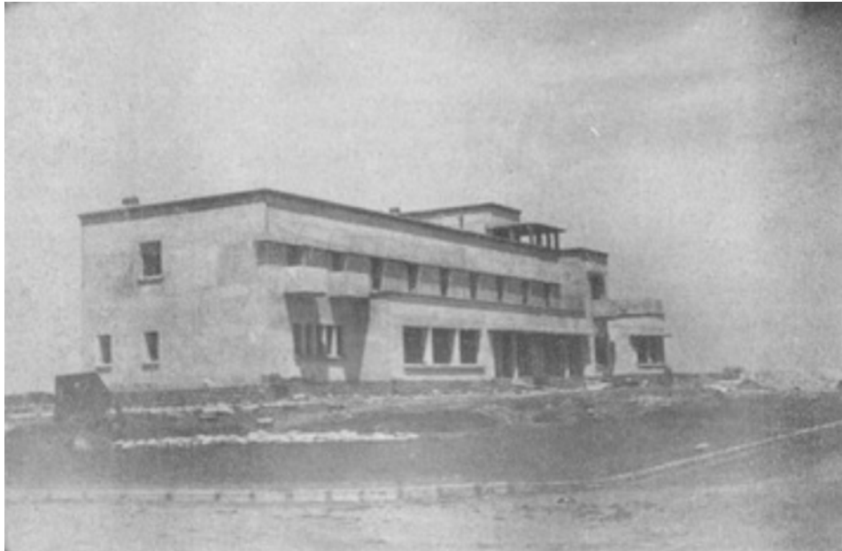
Une des casernes de l'aviation à Port-Lyautey (en construction — mai 1938)
