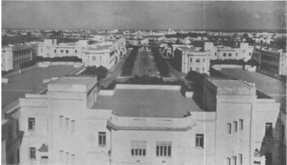
Vue d'ensemble des terrasses de l'hôpital militaire de Casablanca
