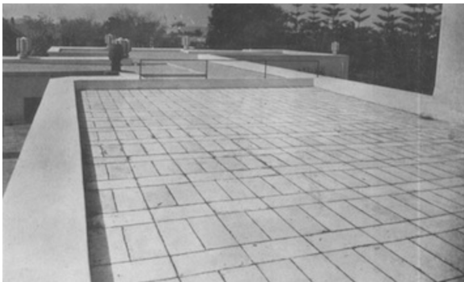
Étanchéité Ruberoïd avec protection ruberdal (pouponnière de Casablanca)
