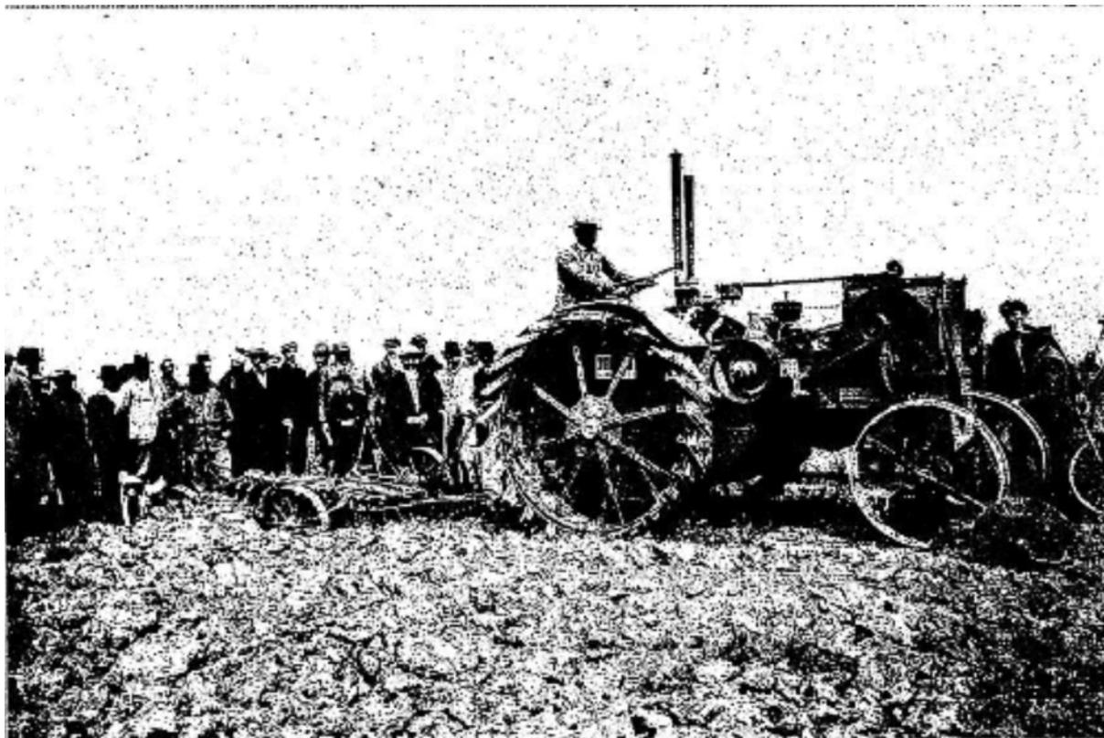
Le tracteur « Titan » labourant avec une charrue à quatre socs.
