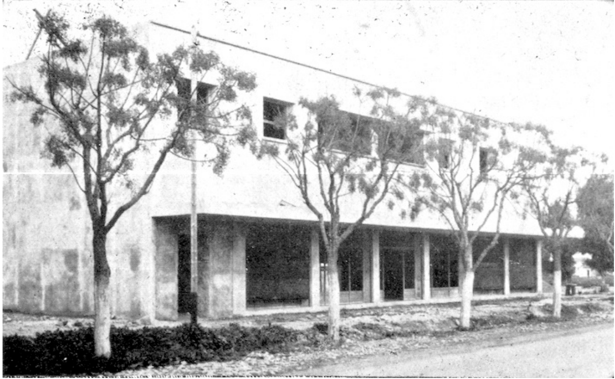
Succursale de Sidi Slimane (en construction)
