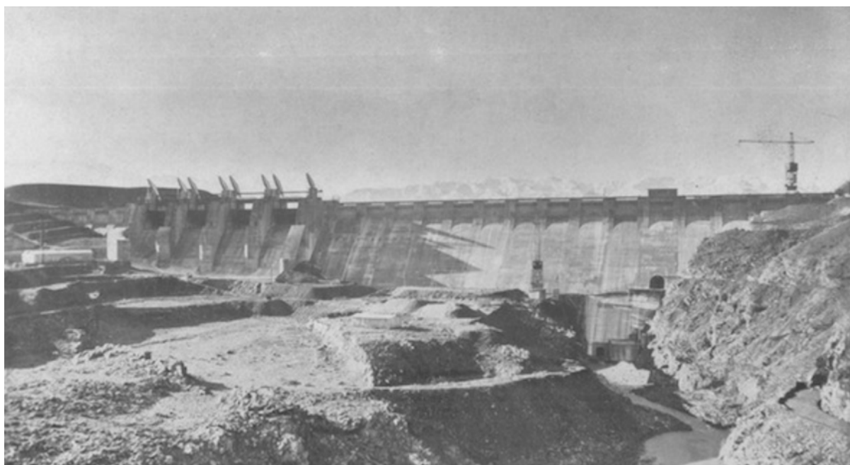
Le barrage de l'oued N'Fis
