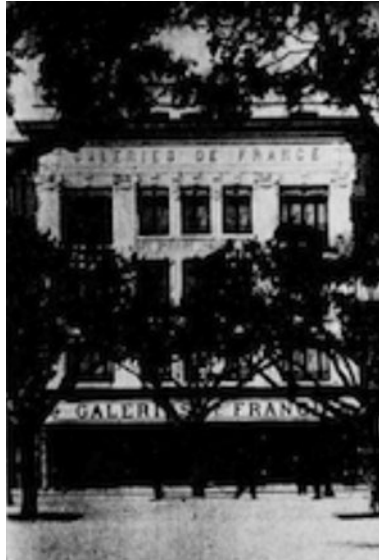
Façade principale des Galeries de France
