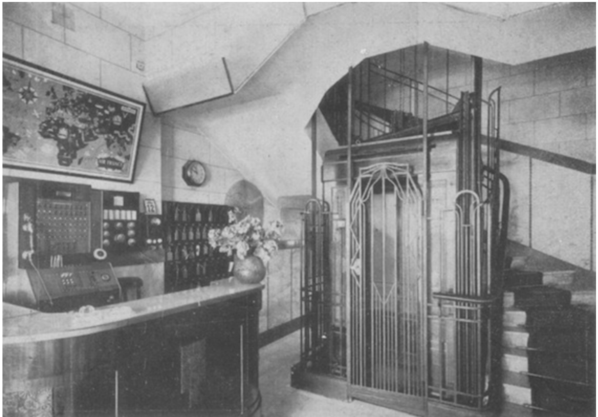
L'entrée et la cage de l'ascenseur
