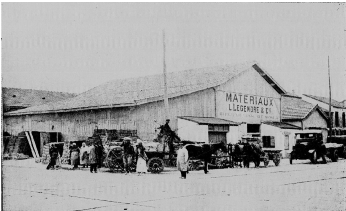
Magasins et entrepôts de l'arrière-port de l'Agha de la Maison Legendre
