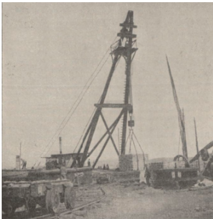
FIG. 34. — Machine à mâter de 50 tonnes.
