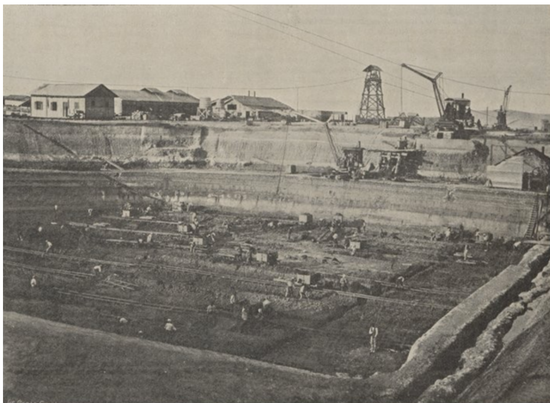
FIG. 12. — LE PORT DE BIZERTE : Fouilles pour la construction d'une forme de radoub.
