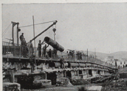
Travaux exécutés à Bône
