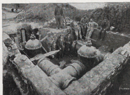
Travaux exécutés à Bône
