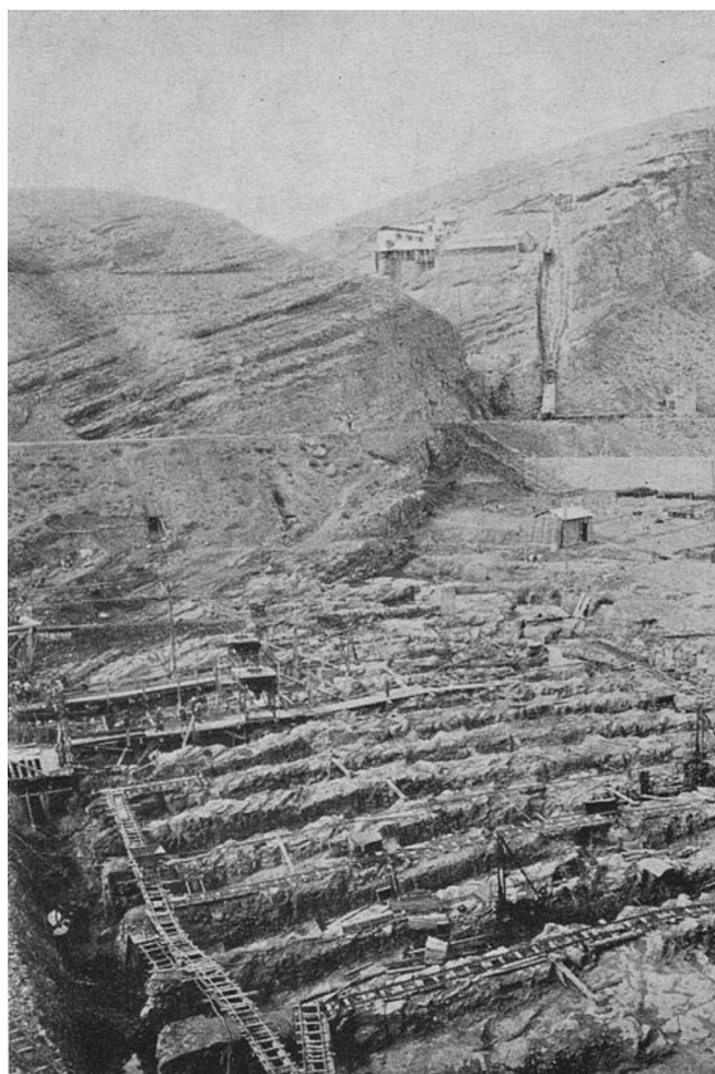
Fig. 12. Barrage du Ksob. — Ancrages des fondations.
