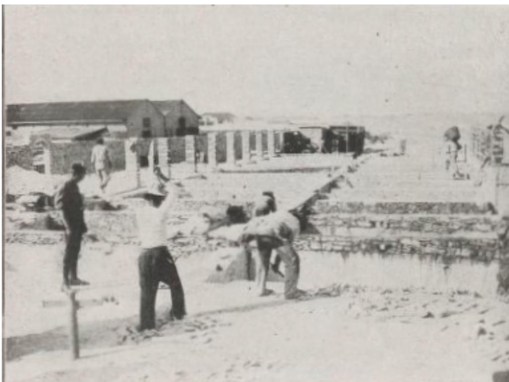
Travaux d'extension cuves à saumure dans le roc
