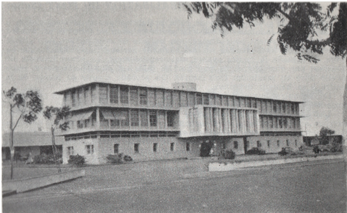
Bâtiment d'exploitation du port d'Abidjan. Réalisation de l'Entreprise générale abidjanaise (ENGA).
