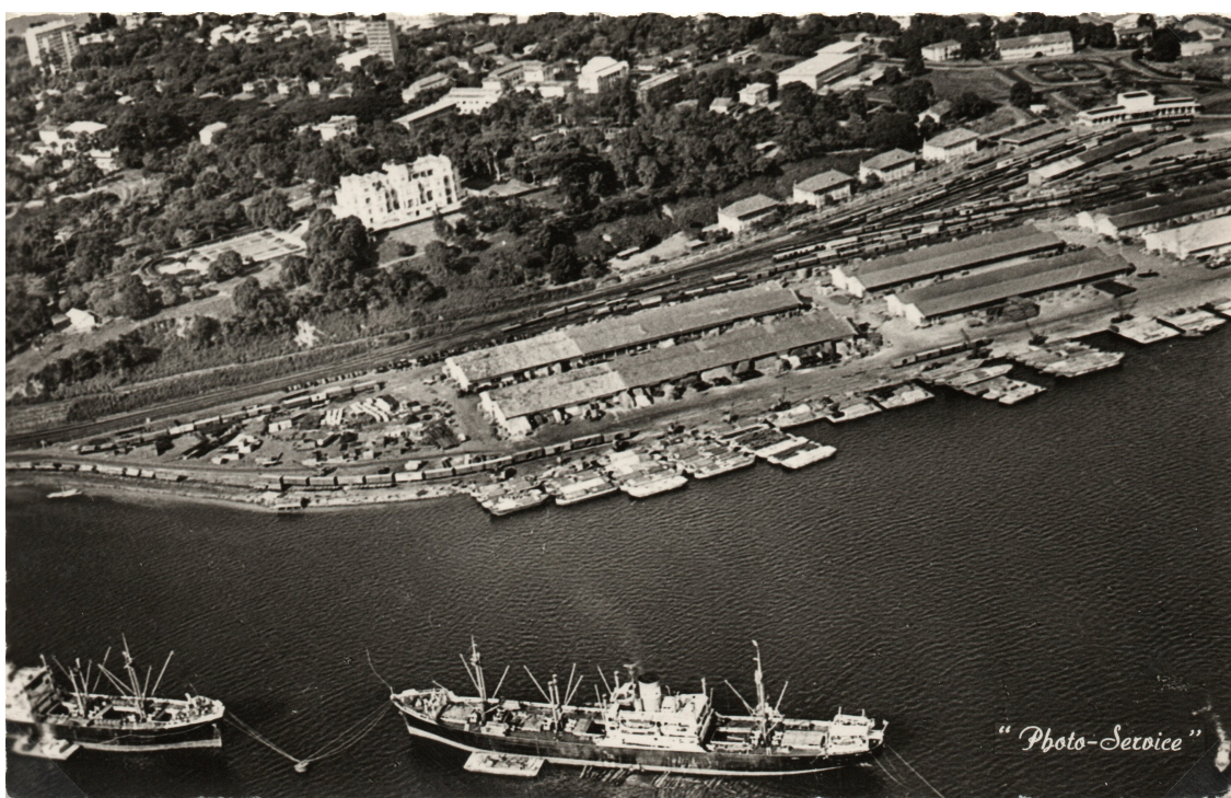
Abidjan. — Le port sur la baie du Banco, dominé par le palais du gouverneur.
