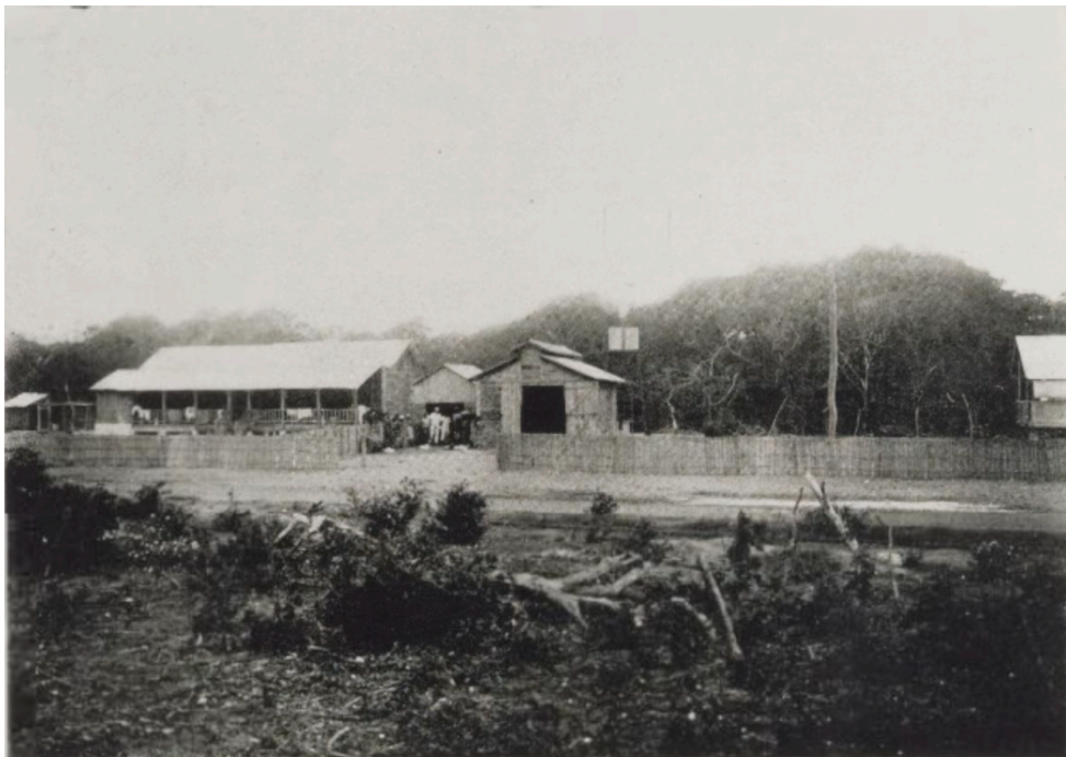
Campement des ouvriers et monteurs du nouveau wharf
