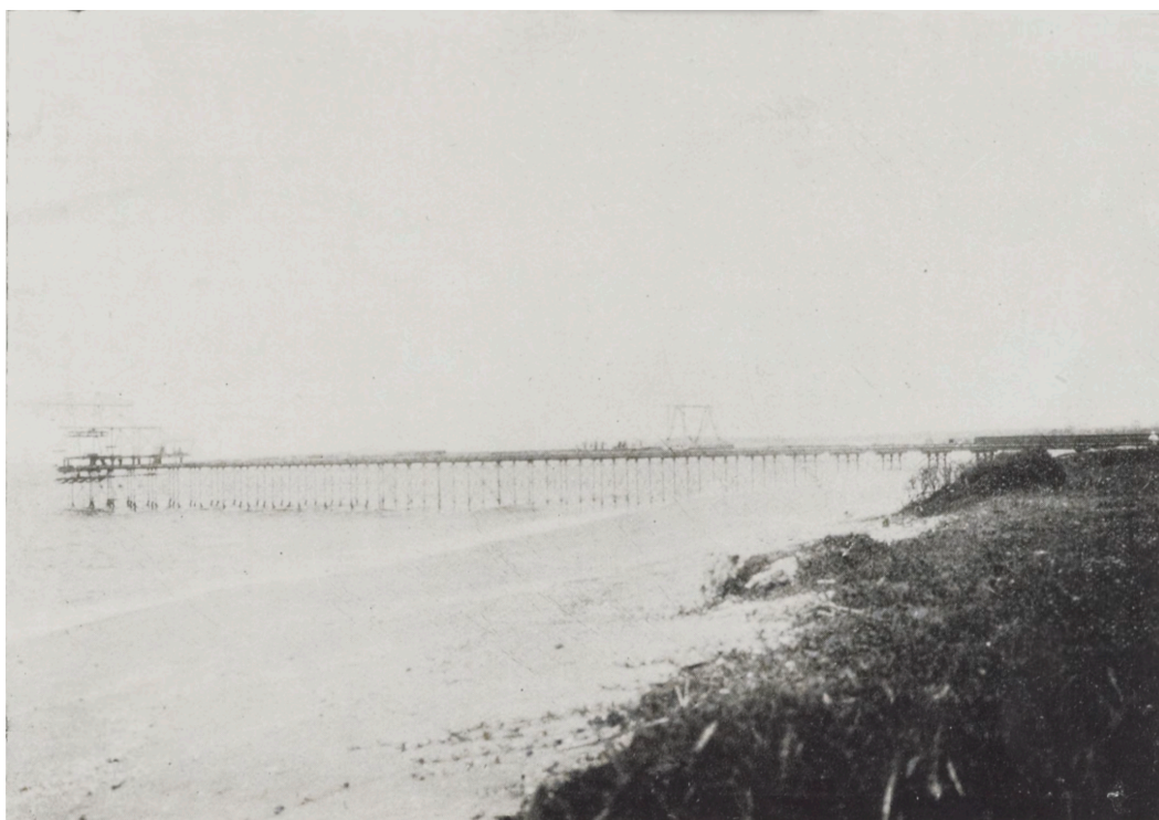
Port-Bouët. — Le nouveau wharf (état actuel)
