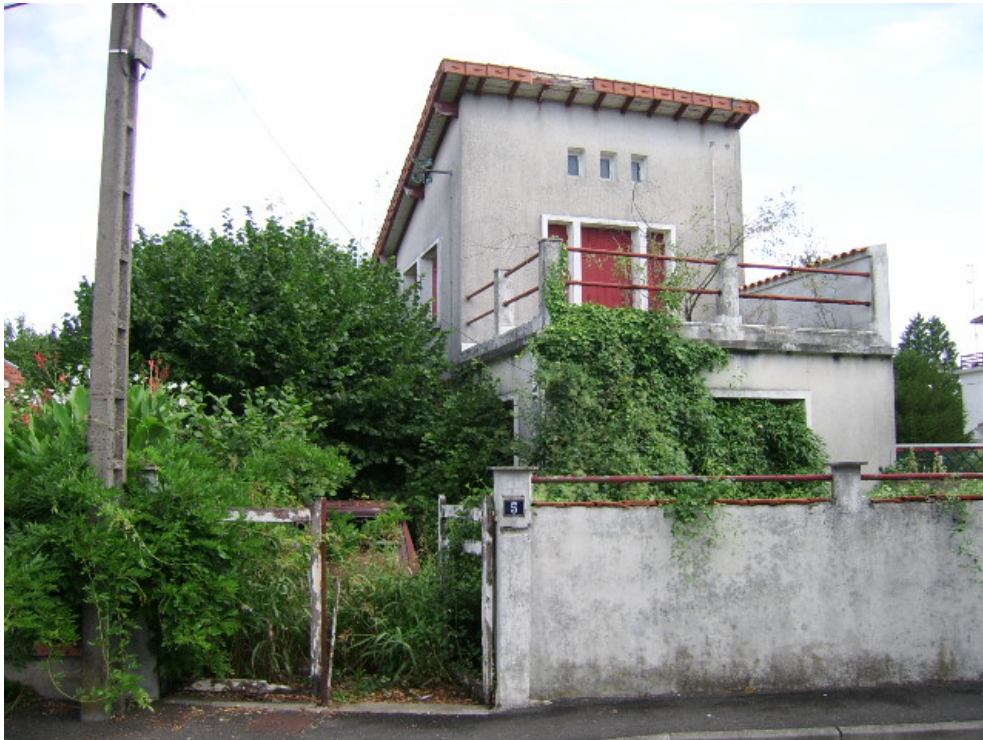
Soyaux, rue des Quinconces, 5 : la maison Etchaburu à l'abandon (2000)
