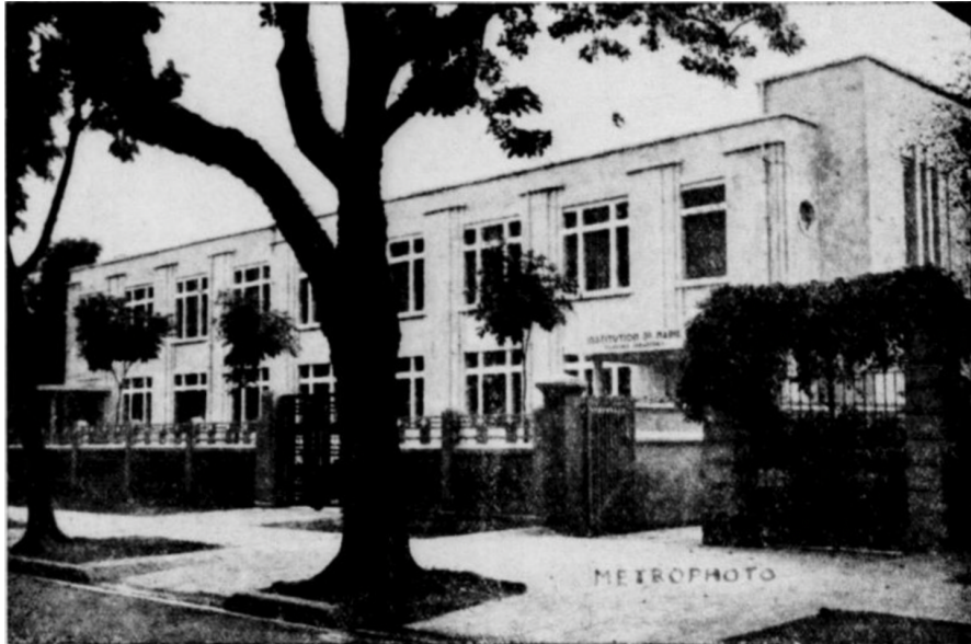
Façade du nouveau bâtiment annexe (Métrophoto)
