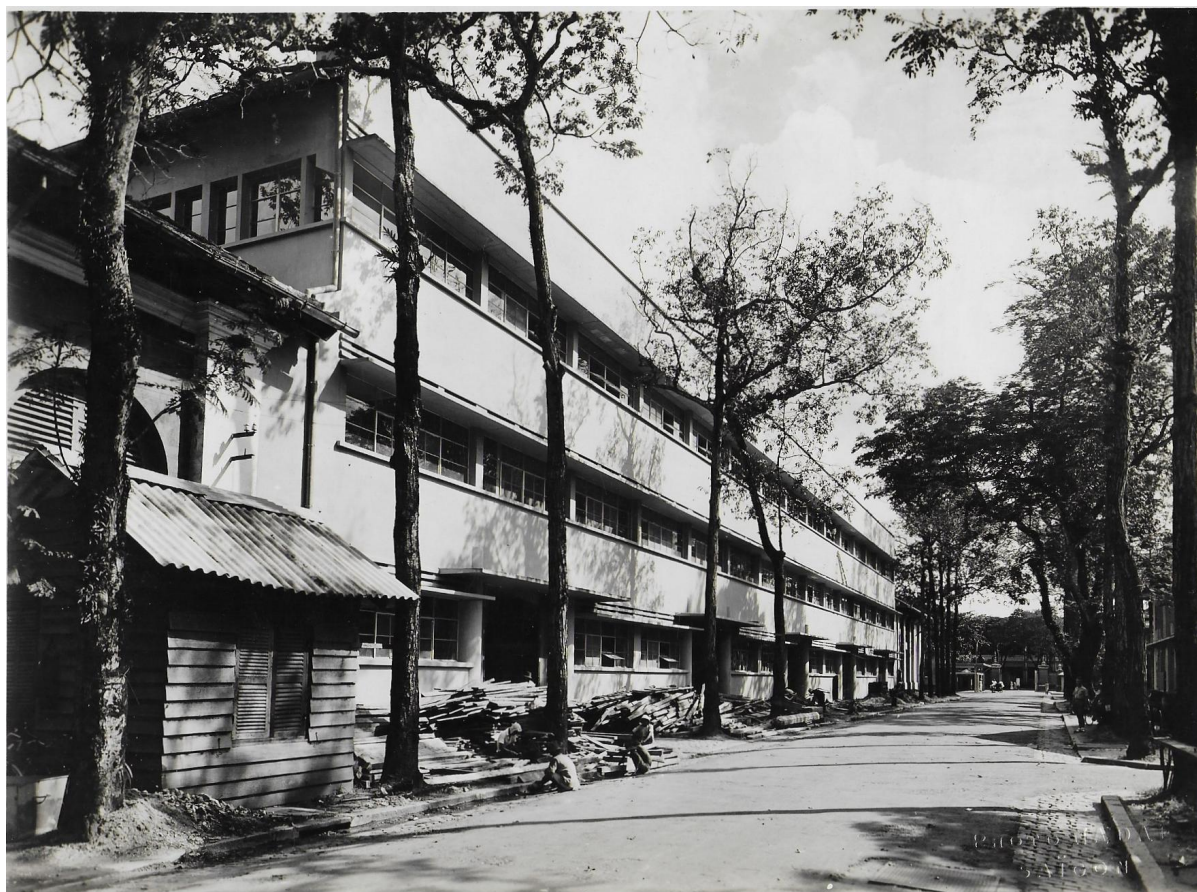
Une partie des nouveaux bâtiments de la Direction des constructions navales servant d'atelier au rez-de-chaussée et de magasin aux 1 er et 2 e étages. Au fond, l'entrée de l'arsenal. Photo Nadal, août 1942. Coll. Gérard O'Connell
