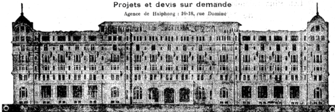
Hôtel de Pékin — (Construit par la maison BROSSARD MOPIN ET C ie )
