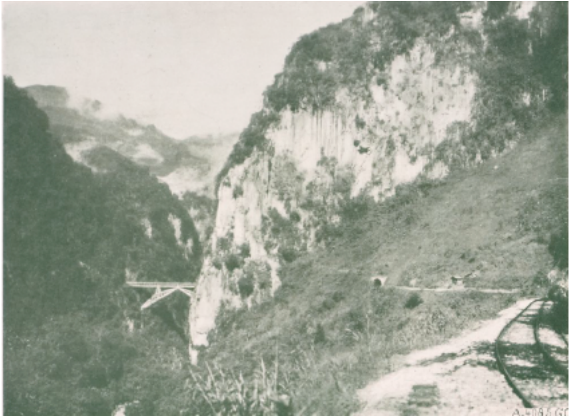
Chemin de fer du Yunnan. — Pont sur arbalétrier
