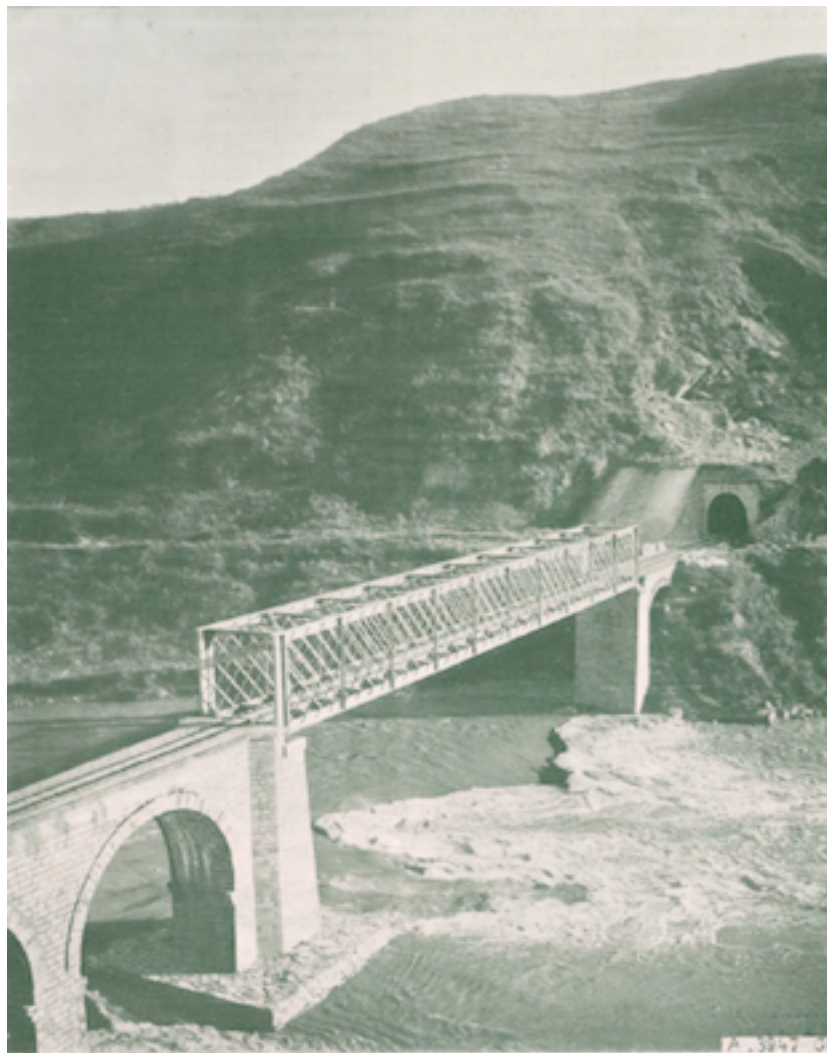
Chemin de fer du Yunnan. — Pont métallique au km. 380 +900
