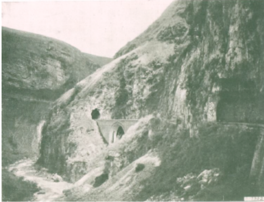
Viaduc dans le déversoir, près e Yunnanfou (km. 416)
