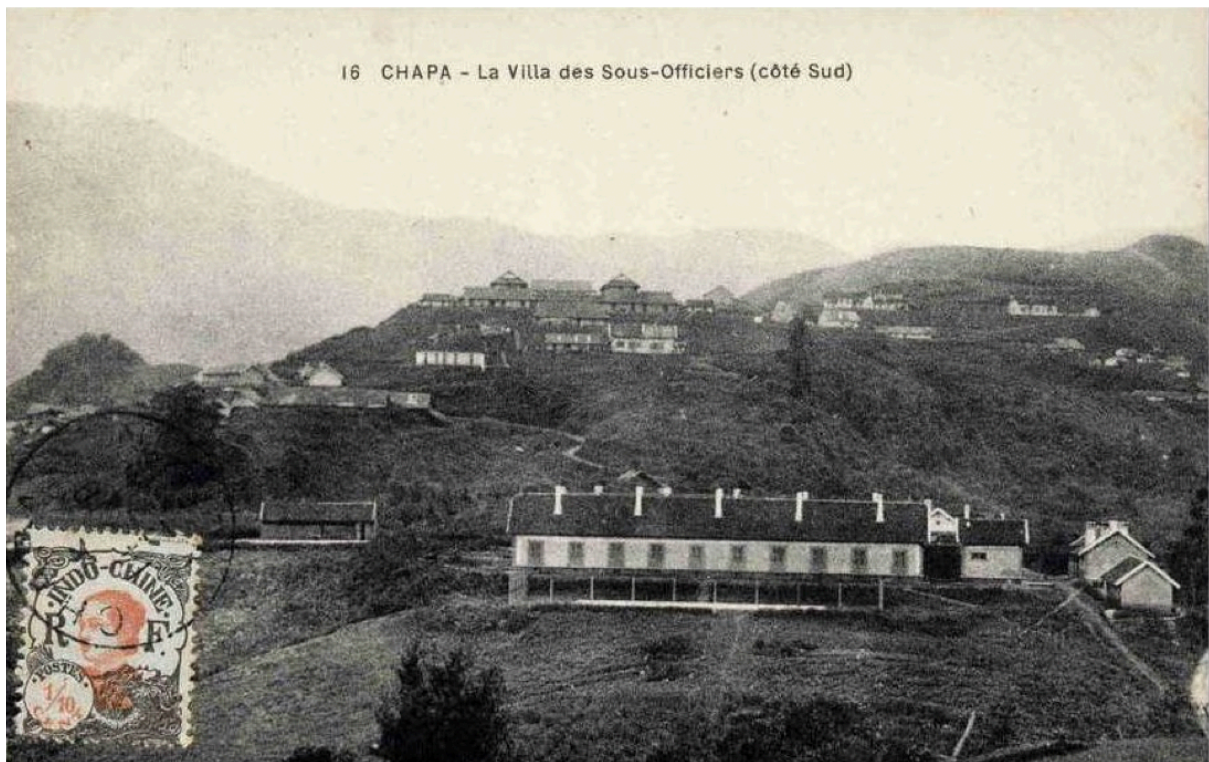
www.indochine-souvenir.com/photos/to/monu/ Chapa. — La villa des sous-officiers (côté Sud)
