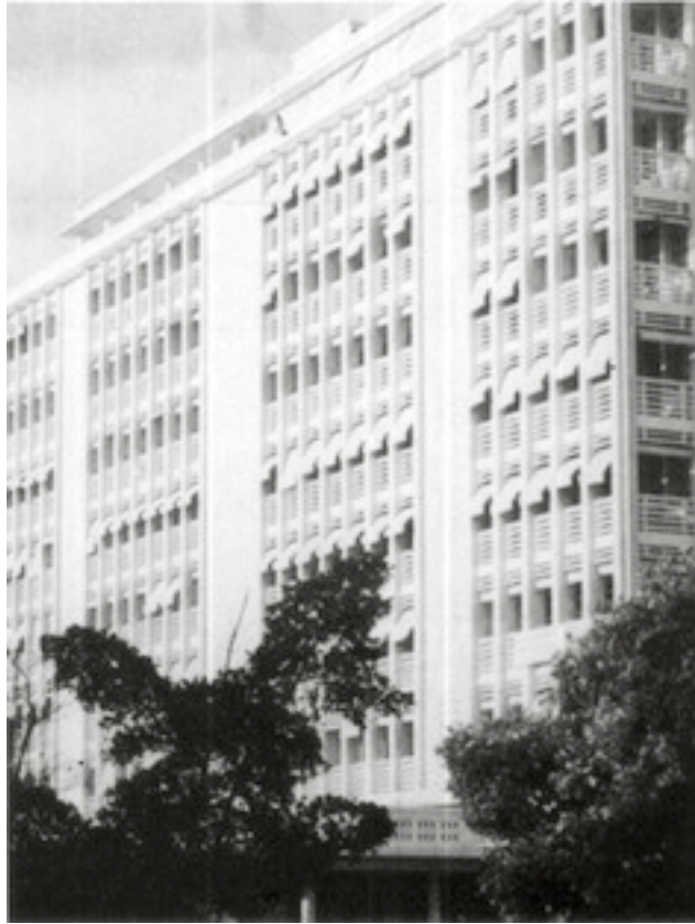
Dakar, 1952. — Immeuble Maginot
